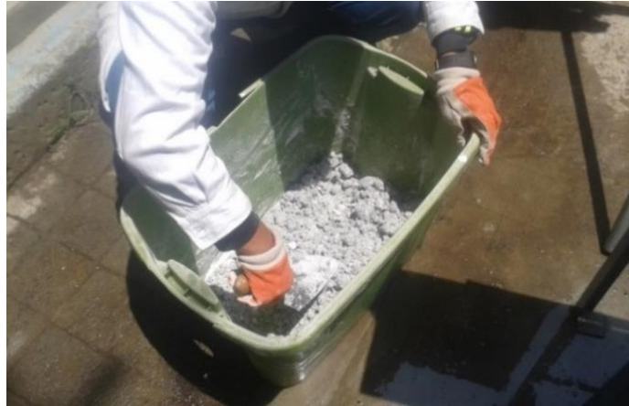
Figura 14. Homogenización de la mezcla
