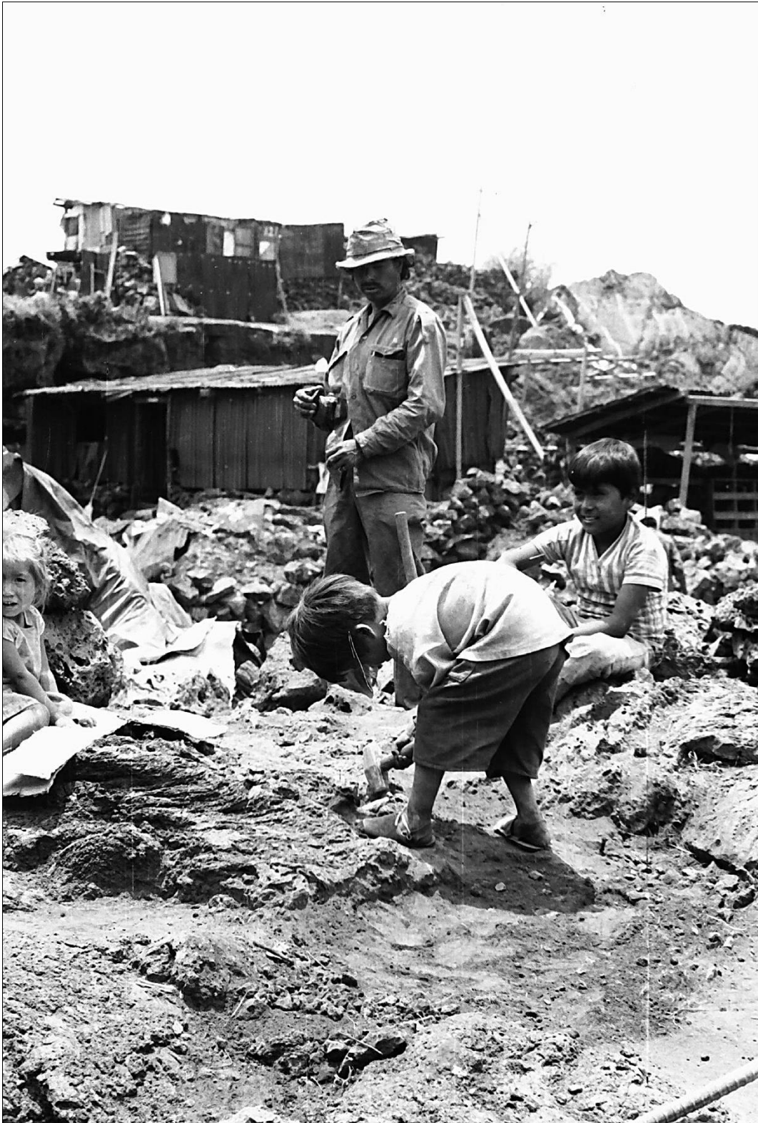
Trabajo familiar en la nivelación del terreno y la construcción de su vivienda en Santo Domingo de los Reyes, 1972. Fotografía: JVAM
