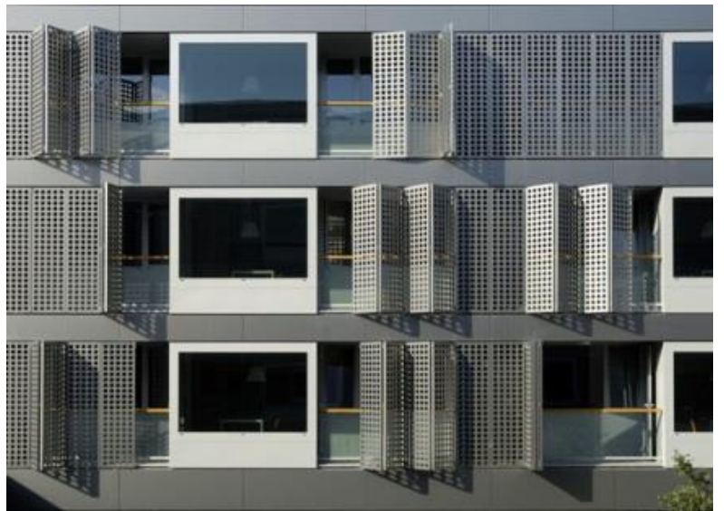
Sistema de parteluces para habitaciones Nucléo de Servicios desde patio interior Fachada y el ritmo que guarda
