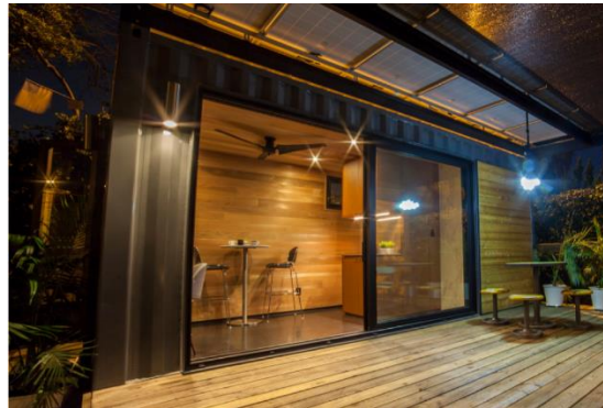
Figura 16. Vista exterior del Modelo NOS1 terminado. (New Old Stock, 2016).
