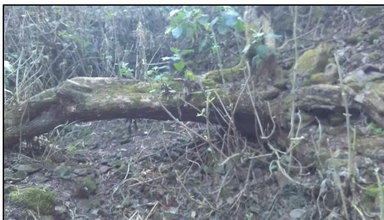
Figura 4.5: Se muestra un árbol caído producto del derrumbe de material rocoso en la ladera de la imagen anterior unos metros separados uno de otro punto, así como con la siguiente, pero que se encuentran en el área.
