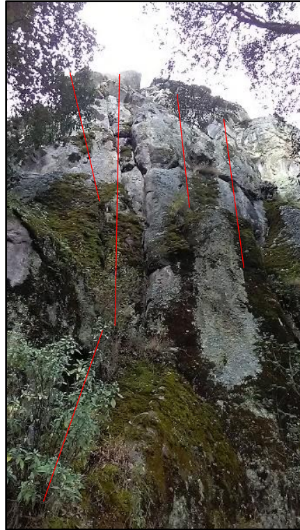
Figura 4.7: Este muro se encuentra con visibles fracturas, lo que evidencia las características geológicas de la región, las rocas son totales y presentan fracturas verticales como se señalan con las líneas en rojo, algunas de estas fracturas llegan hasta la base.
