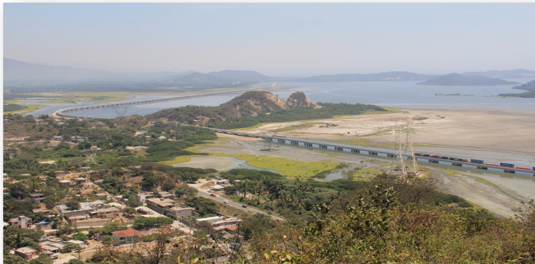
Figura 21 Desvió Ferroviario Cuyutlán
