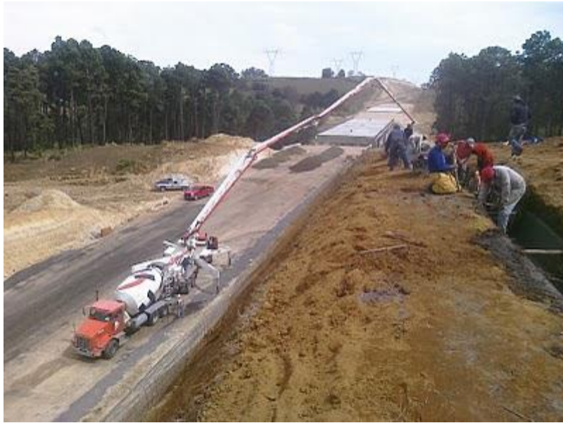
Fig. 11: Realización de contra cuneta en obra.
