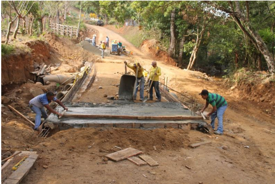
Fig. 23: Construcción de vado en obra.
