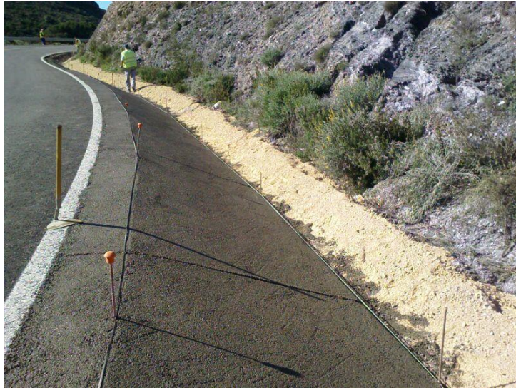
Fig. 2: Ejemplo de drenaje longitudinal.
