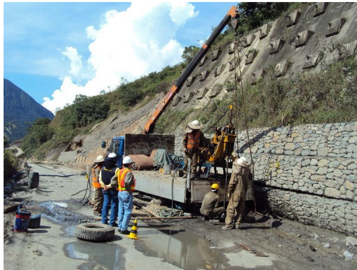
Fig. 31: Realización de estudios geológicos y geotécnicos.
