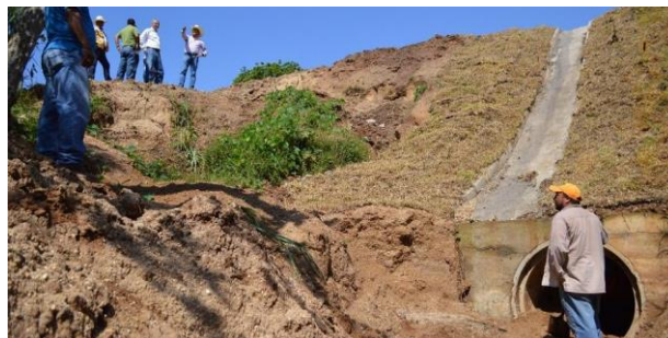
Fig. 13: Supervisión de elaboración de lavaderos.
