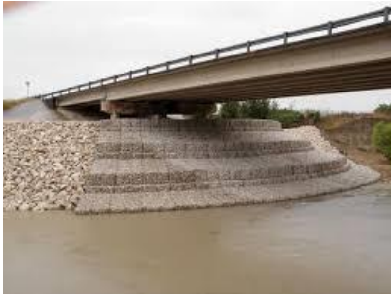
Fig. 33: Protección contra socavación en puentes.
