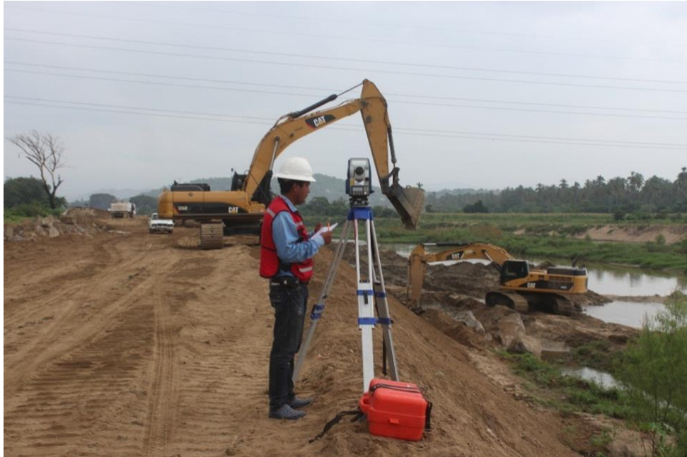
Fig. 32: Estudios topográficos en obra.
