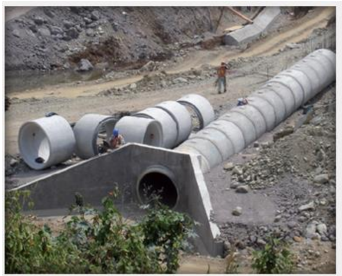
Fig. 19: Alcantarilla de tubo de concreto.
