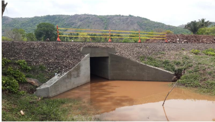
Fig. 18: Alcantarilla tipo marco de concreto.
