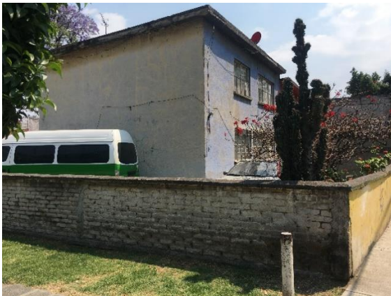
Fotografía 20. Vista vivienda original localizada en Sur 85
