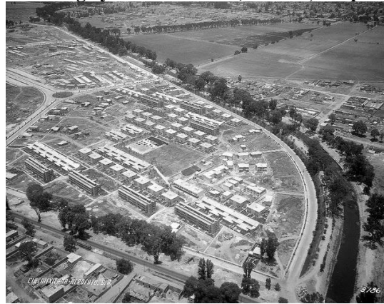
Fotografía 5. Unidad Modelo (Unidad Vecinal 9), entre av. Río Churubusco, Calzada de la Viga y Av Oriente 160, Modelo, Iztapalapa, 1952
