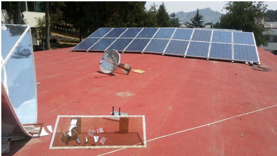
Ilustración 30 Vista de la azotea de la Facultad de Ingeniería en la UAEM, campus El Cerrillo.
