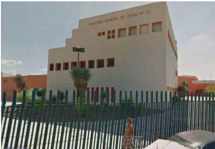
Hospital General de Zona N° 51, Durango
