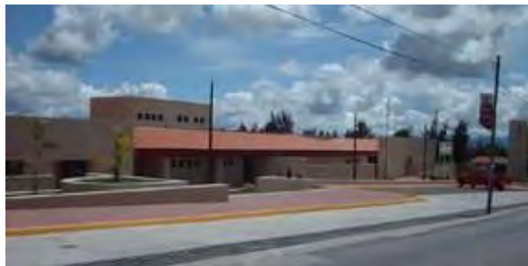
ISSEMYM Hospital Regional Ixtapan de La Sal consta de 8 consultorios de consulta externa y especialidad y 20 camas censables para las especialidades básicas.
