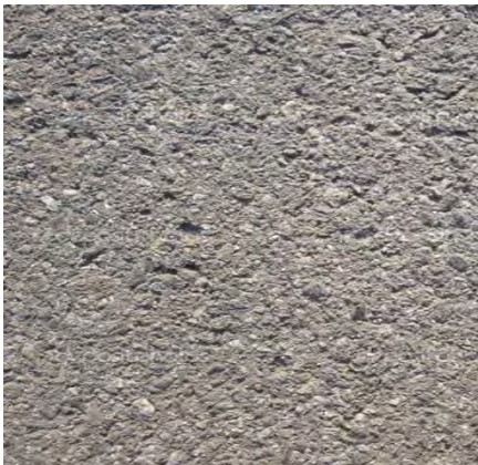
P-11. Concreto Mca: Hecho en Obra Color: Natural Tipo: Pulido, endurecido y sellado
