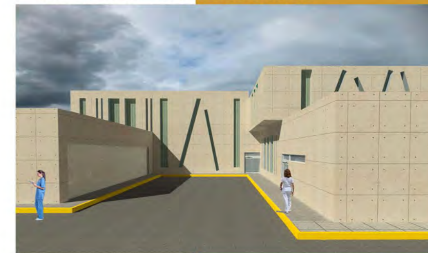
VISTA DE LA ZONA DE SERVICIOS
