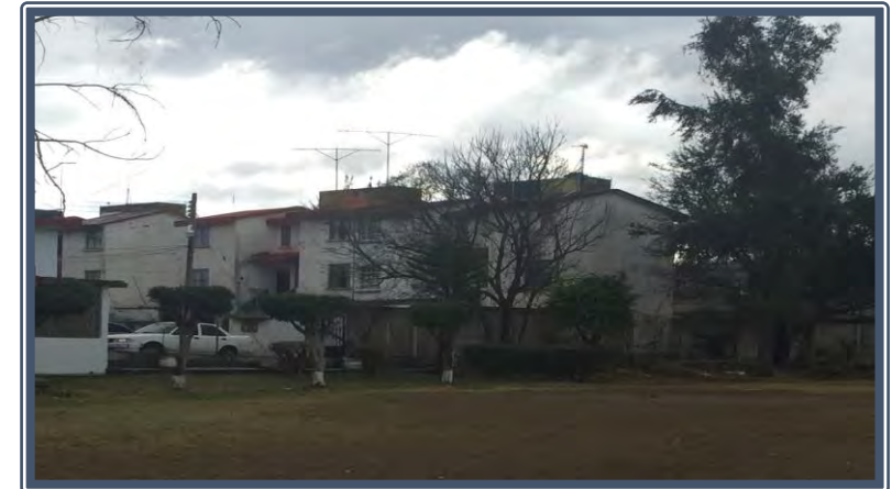
Foto 7.- La foto muestra que nuestro predio tiene colindancia con una unidad habitacional con casas de 3 niveles, no tiene barda solo malla de protección.
