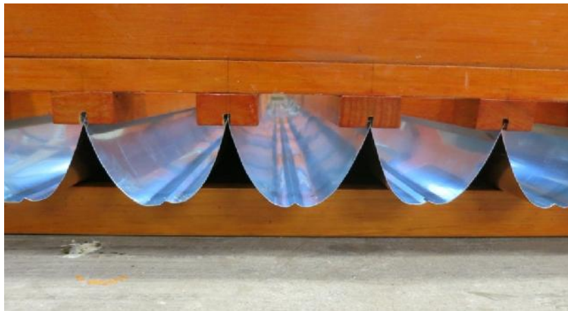
Figura 25. Prueba de colocación de las láminas en el molde de madera.
