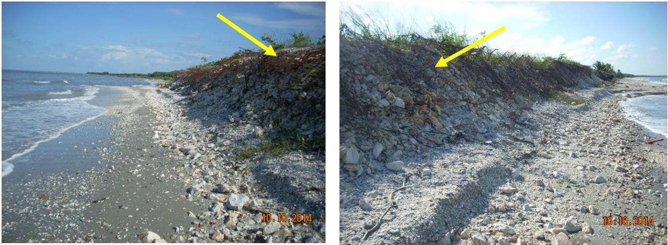
Figura 7.10. Playa El Zacatal, se observa que los gaviones colocados para proteger el sitio, han sido derribados por efecto del oleaje presente en la zona.
