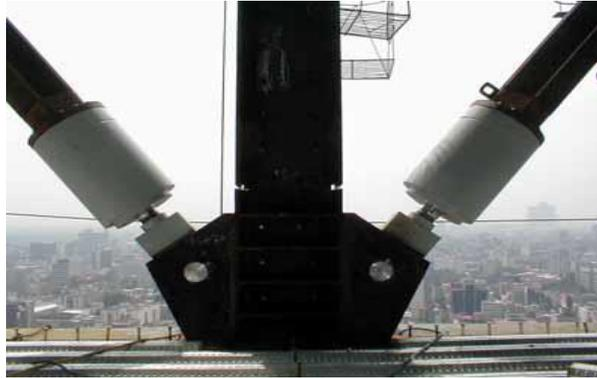
**Figura 1.3. Amortiguadores viscosos instalados en la Torre Mayor (Taylor y Katz, 2003)**
