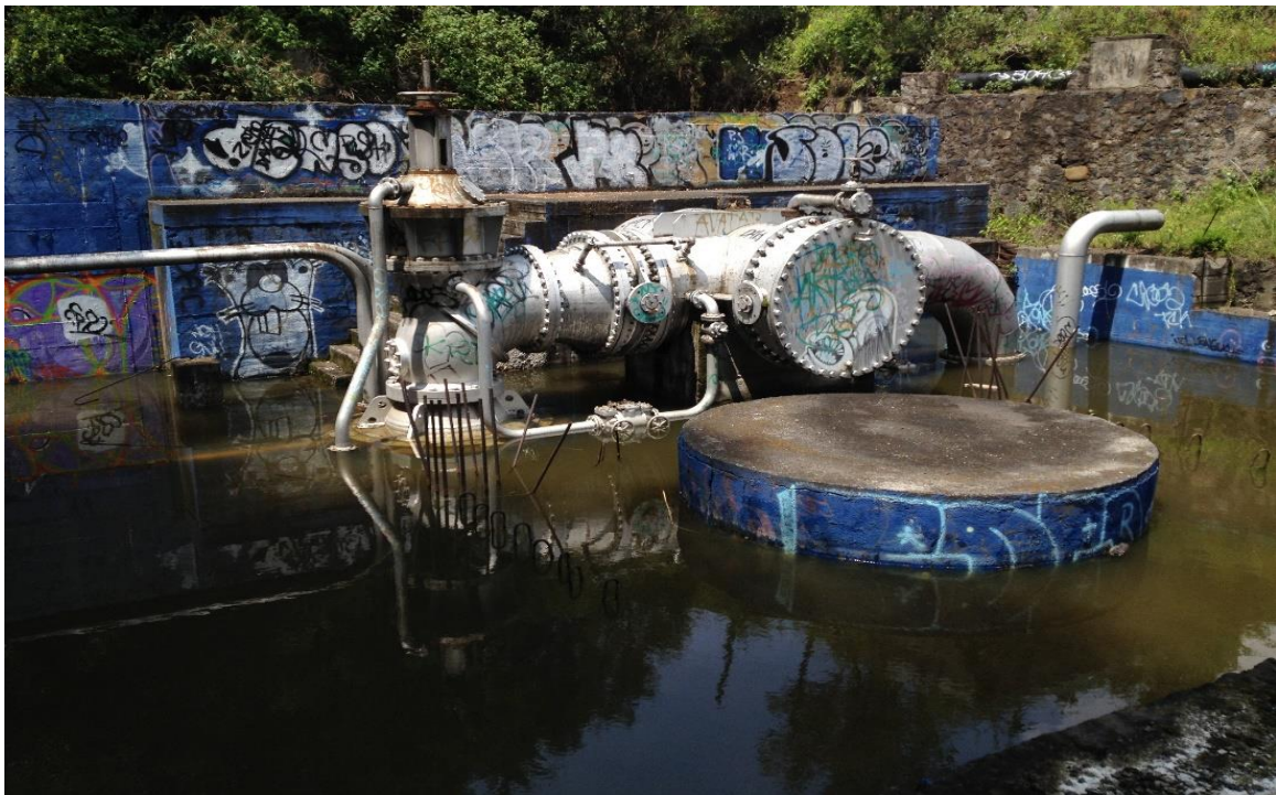
Rebombero en la salida al túnel de la Caída El Borracho. Fuente: Marco Ponce, Inspección en campo, 2018
