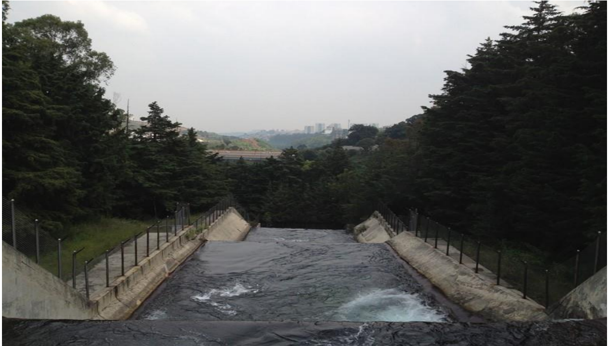
Caída El Borracho. Fuente: Marco Ponce, Inspección en campo, 2018
