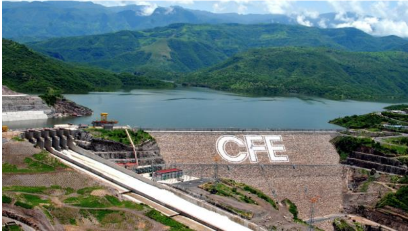
Figura 19. Central hidroeléctrica “La Yesca” Nayarit. Fuente: FORBES
