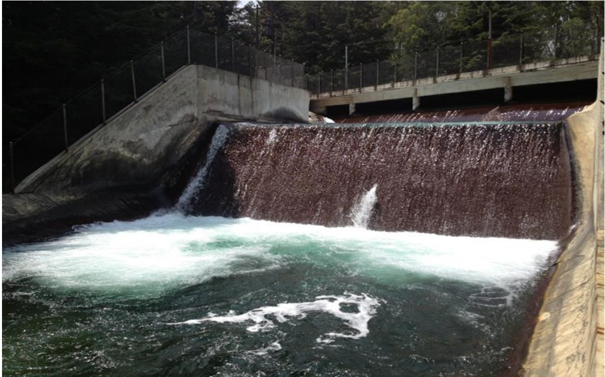
Caída El Borracho. Fuente: Marco Ponce, Inspección en campo, 2018
