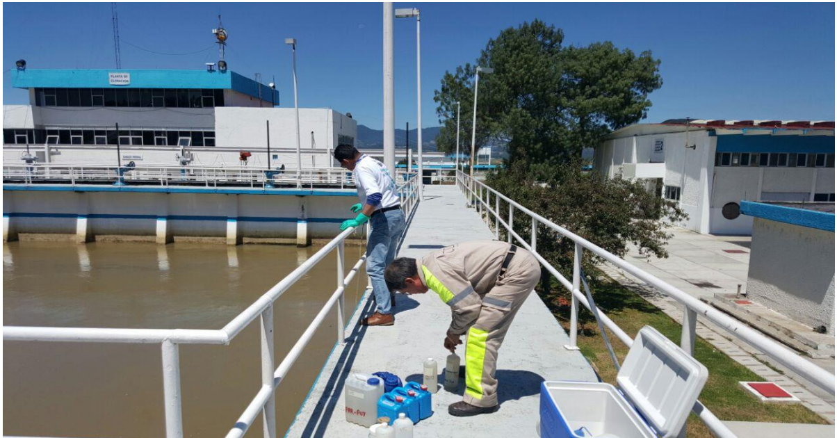
Personal laborando en el tratamiento de la planta de potabilización. Fuente (SACMEX).
