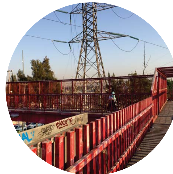
[Imagen 27] Puente peatonal.
