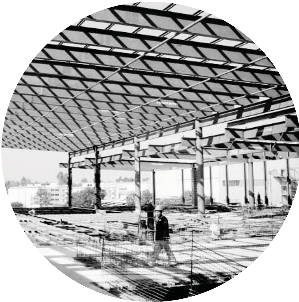
[Imagen 57] Estructura CETRAM El Rosario.
