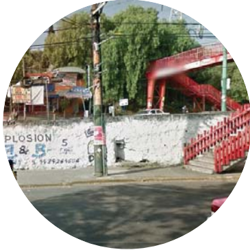
[Imagen 82] Puente peatonal.
