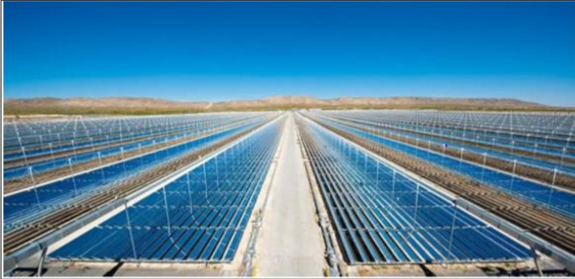
Imagen 2.12. Planta Termosolar de espejos lineales Fresnel, Thermosolar Power Plant Puerto Errado 2, Murcia, España, 2012
