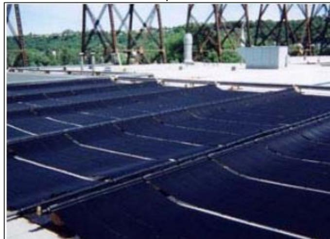
Imagen 2.2. Colector solar sin cubierta
