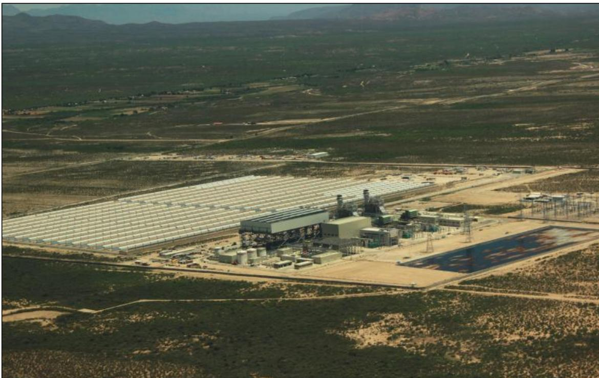
Imagen 2.9. Planta de Ciclo Combinado Integrado con Campo Solar, Agua Prieta II, con un campo de colectores parabólicos de 14 MWe.
