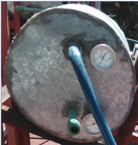
Imagen 4.12. Termómetros instalados en el tanque de almacenamiento
