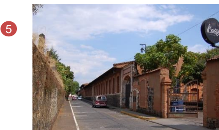
5 La nave poniente de la fábrica San Pedro, actualmente es un salón para eventos y un bar.
