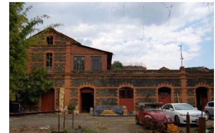
Edificio contiguo a la fábrica, actualmente la familia Illsley habita el segundo nivel, la planta baja se utiliza como bodega.
