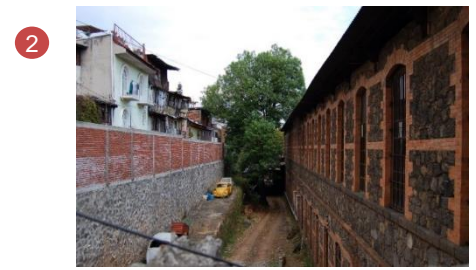
2 Callejón y costado de la fábrica, la diferencia de 6 metros altura es un límite físico y no existe ninguna relación con la fábrica.
