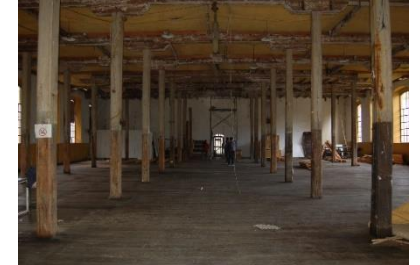
Planta alta de la nave oriente, se observa su sistema de columnas y travesaños de madera.
