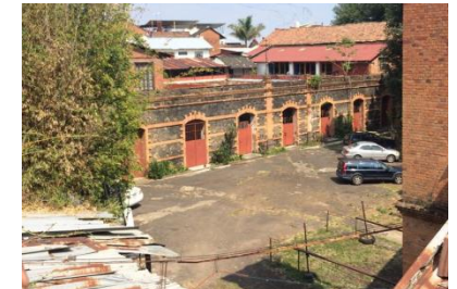
Estado actual de la plaza que divide el volumen de la fábrica del volumen de las bodegas.
