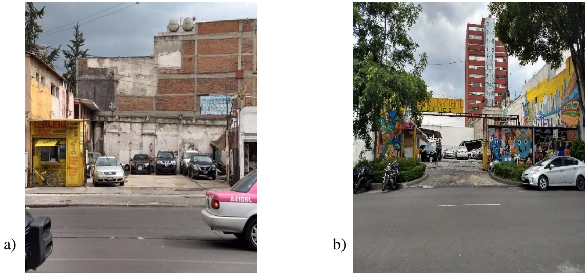
Figura 4.7. Estacionamientos encontrados durante la inspección de banqueta: a) Estacionamiento con clave CUA-141 y b) Estacionamiento con clave CUA-121.
