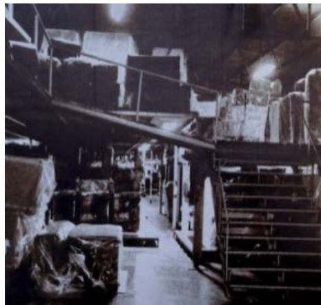
Fig.5 - Almacén de producto terminado, 1989.
