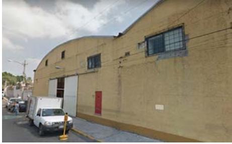
Fig.110 - Fachada de fábrica SOFAMEX.
