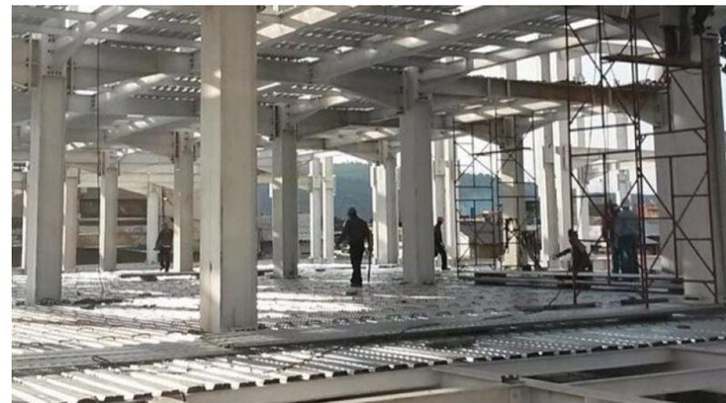
El sistema estructural estará formado por columnas y traveses de concreto reforzado colado en sitio,
