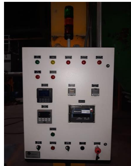
Fig. 36 Vista de frente del tablero de control, con las pantallas de los tres controles instalados
