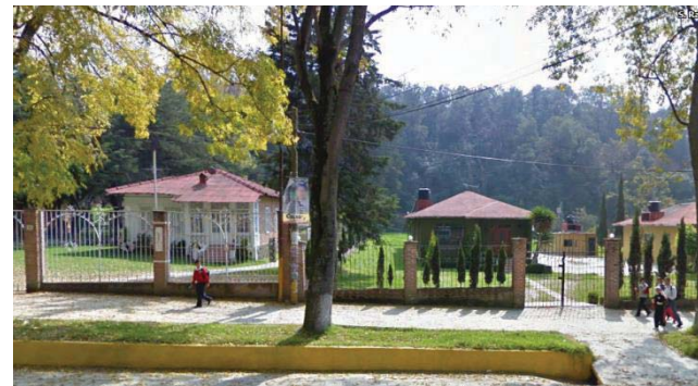
Fig. 47 Vista 2 de calle San Rafael, Fachada tipo de residencias (Google Street View 2013).
