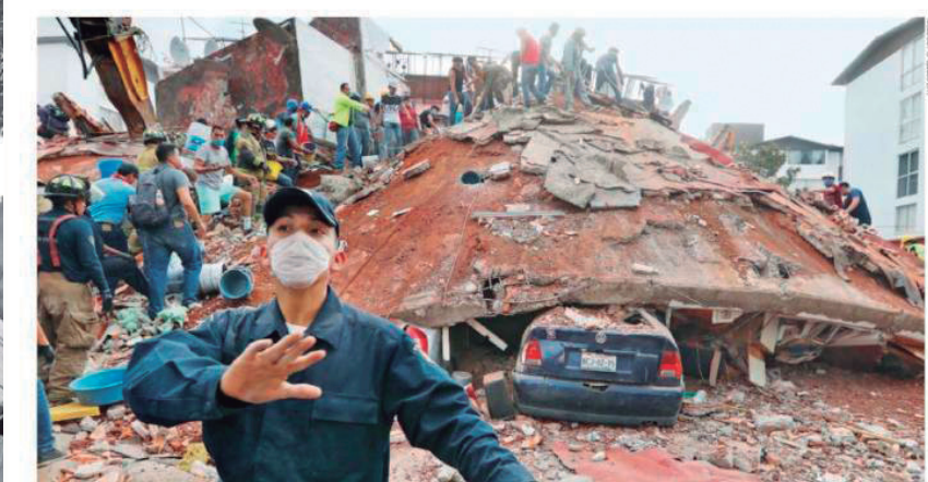
El edificio de cinco pisos ubicado en la calle de Turelos y Viaducto se derrumbó, dejando atrapados a cinco personas.
