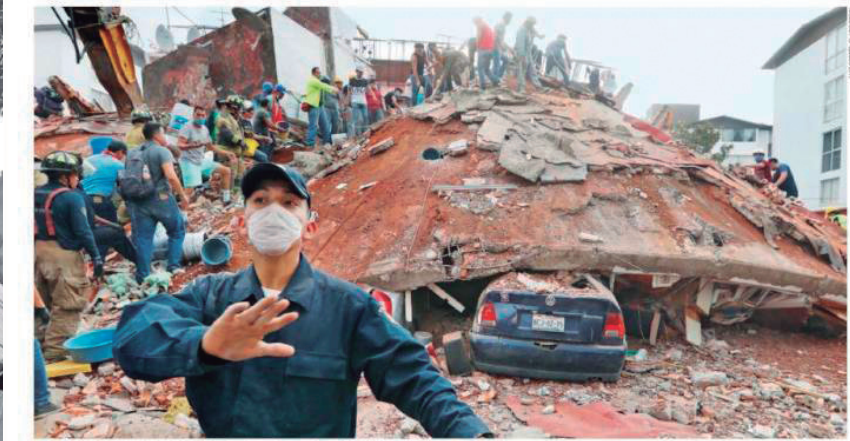
El edificio de cinco pisos ubicado en la calle de Turelos y Viaducto se derrumbó, dejando atrapados a cinco personas.
