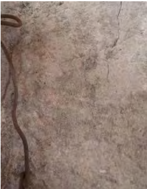
Detalles de las condiciones en las cuáles se encuentra la cara interna del panel, se observan pequeñas grietas y fisuras que no comprometen la conservación del panel, así como diferentes secciones de alambrrón en las esquinas.. Sep-Dic. 2012. Crédito: Virginia Arroyo Rodríguez.
