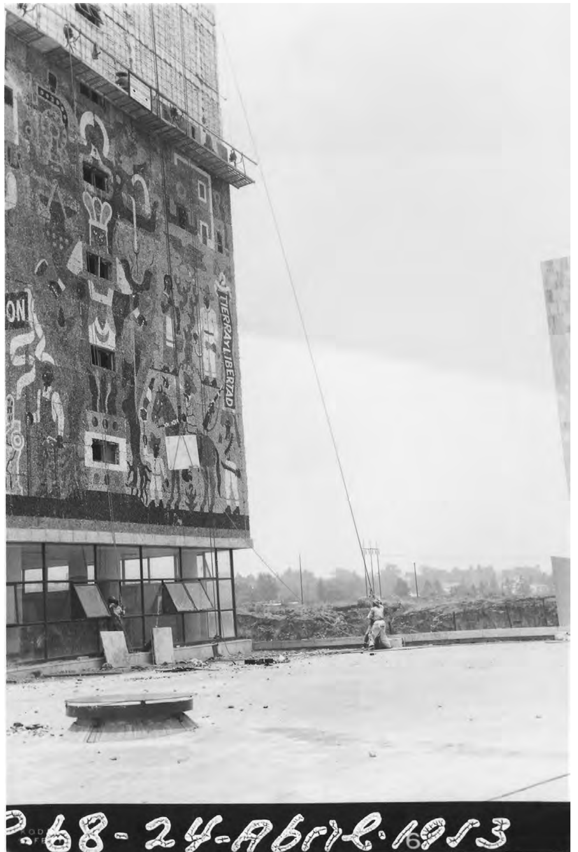
Vista vertical, de la ascensión de las placas del mural. Se ve a un albañil jalando de una cuerda. En el margen izquierdo, fuera de la imagen, la leyenda "P-68-24-abril-1953"; en el reverso las inscripciones manuscritas "BIBLIOTECA. P. 68.- AVANCE DE LA OBRA. ASCENCIÓN DE PLACAS.". S/a. Imagen obtenida en: IISUE/AHUNAM/Colección Universidad, Sección: Construcción de C.U./3456.
