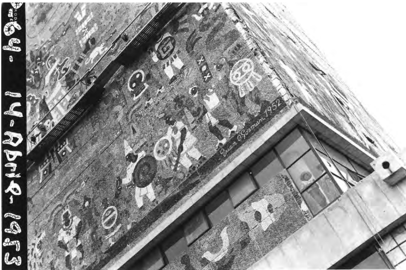
Detalle de enmarcamiento de los paneles en la esquina nor-poniente Imagen obtenida en: IISUE/AHUNAM/Colección Universidad, Sección: Construcción de C.U./3453.
