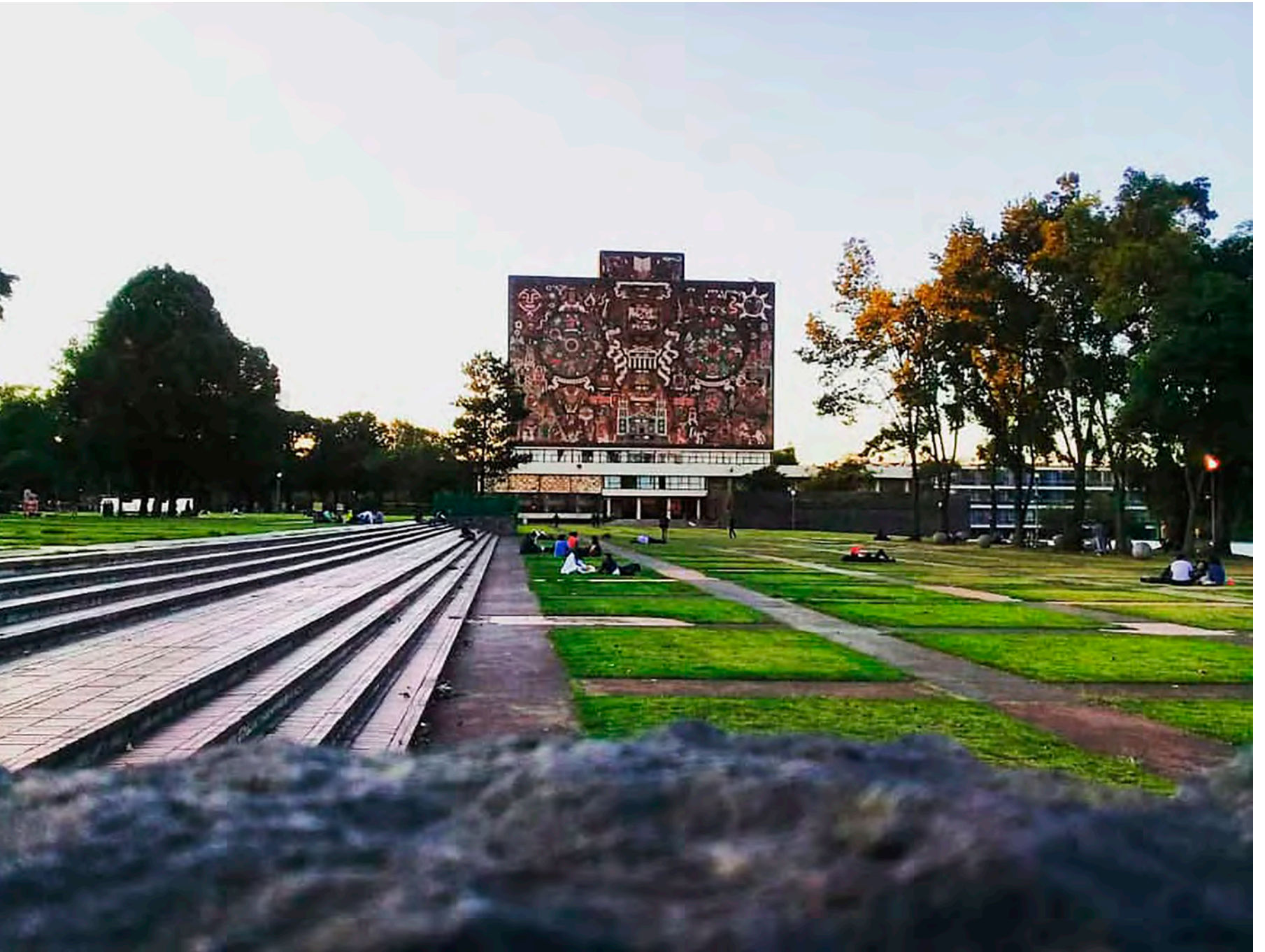
Detalle del manejo de los diferentes pavimentos y materiales que sirven para diferenciar y separar cada uno de los espacios. Imagen obtenida en: http://picbear.online/sandermxinnovations .
