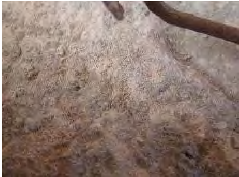
Detalles de las condiciones en las cuáles se encuentra la cara interna del panel, se observan pequeñas grietas y fisuras que no comprometen la conservación del panel, así como diferentes secciones de alambrrón en las esquinas.. Sep-Dic. 2012. Crédito: Virginia Arroyo Rodríguez.
