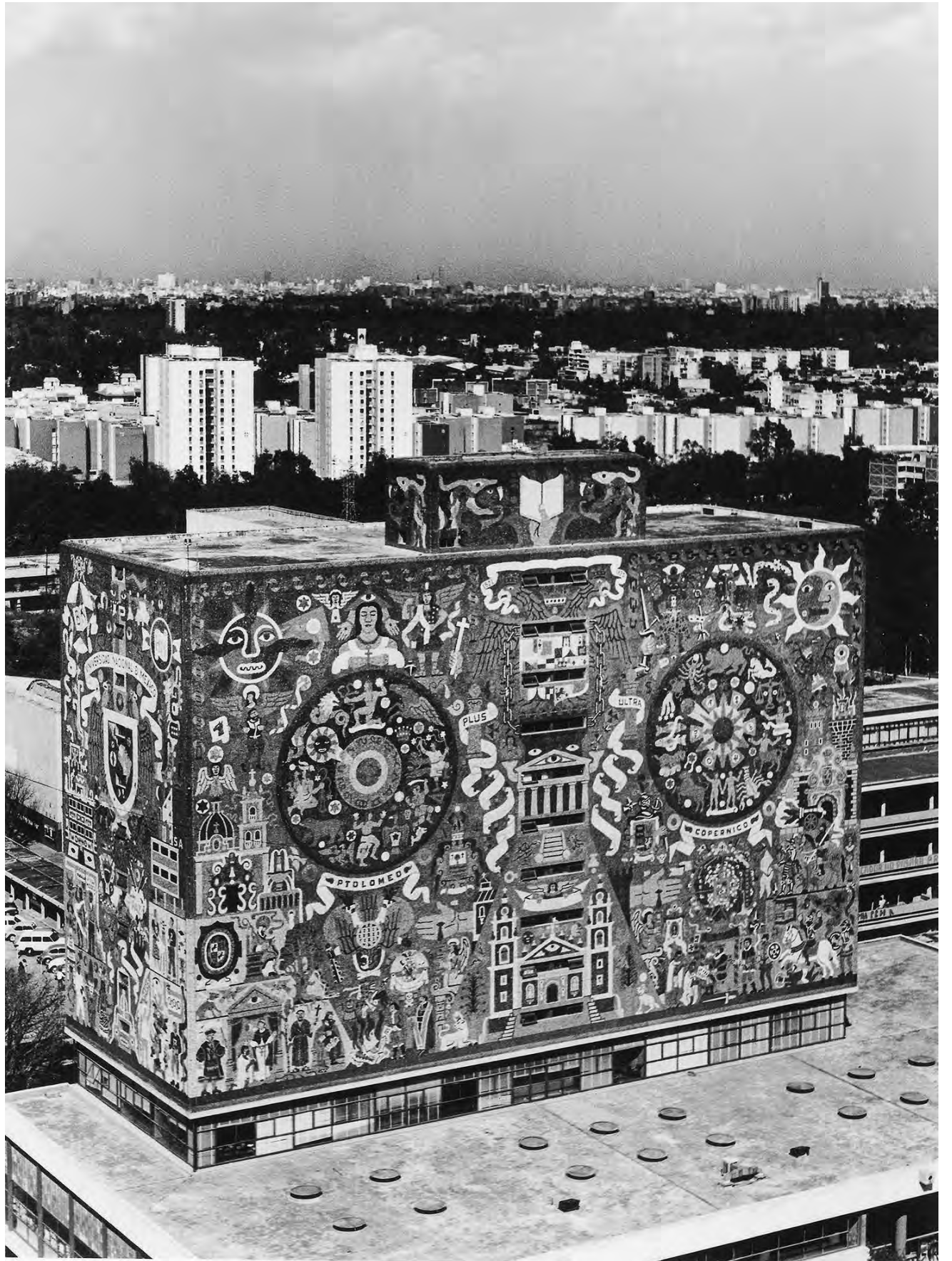
Vista parcial de la parte suroeste de la Biblioteca Central ya terminada. Al fondo, se pueden ver edificios y casas. Autor Raimundo García Cardoso. Imagen obtenida en: IISUE/AHUNAM/Colección Universidad, Sección: Construcción de C.U./3458.2
