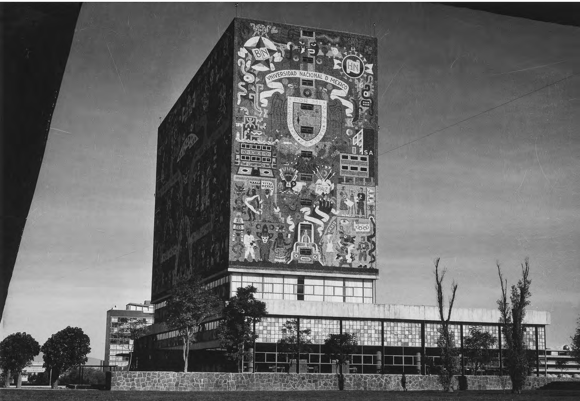
Vista general de la fachada Noroeste de la Biblioteca Central, ya terminada. Imagen obtenida en: IISUE/AHUNAM/ Colección Universidad, Sección: Construcción de C.U./3459
