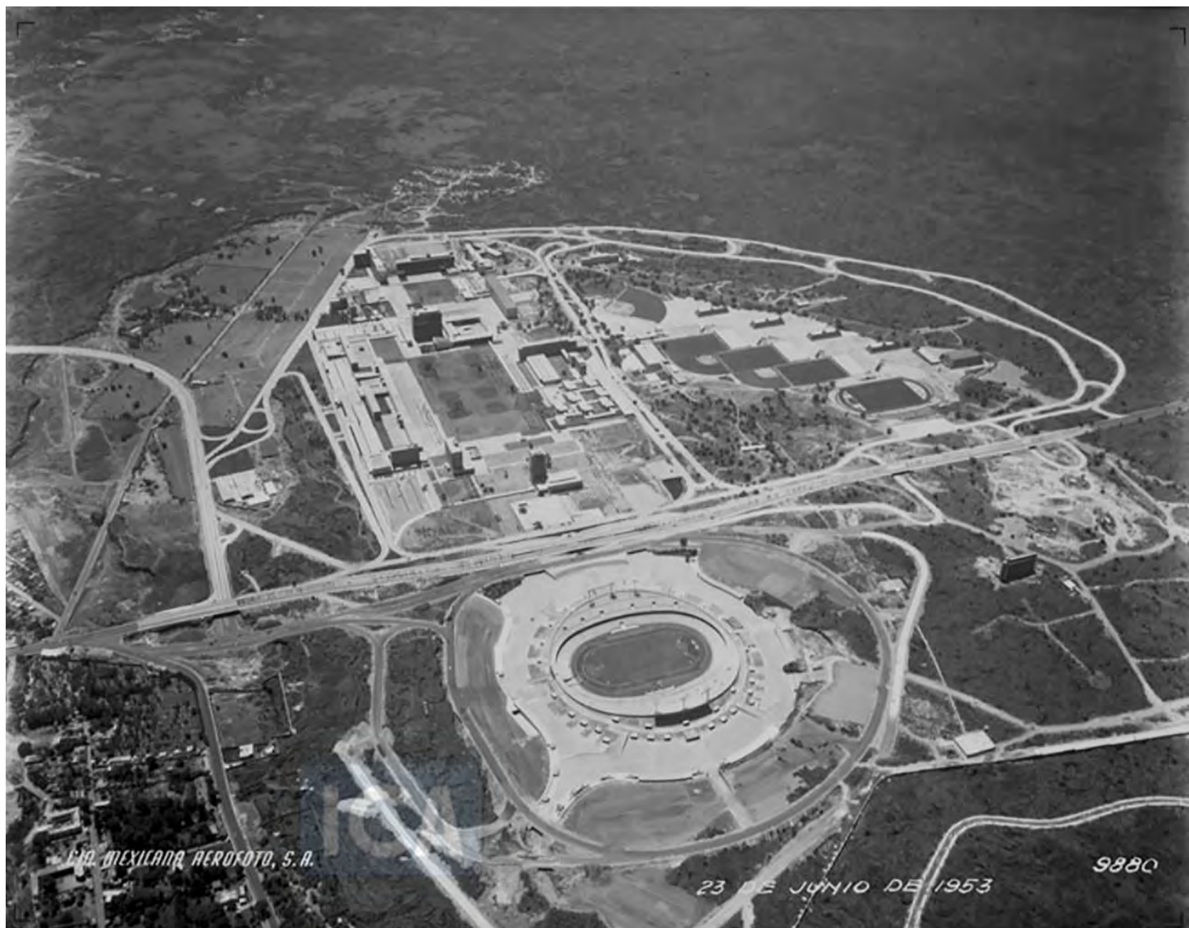
En las imágenes tomadas el 23 de junio de 1953, se observan las fachadas laterales, oriente y poniente, totalmente terminadas; al igual que las fachadas sur y norte. Imágenes obtenidas en: http://www.fundacion-ica.org.mx/colecciones_digitalizadas . Serie Oblicuas, Clave de Control FAO_01_009880 y FAO_01_009883, Fondo Aerofotográfico Acervo Histórico Fundación ICA, A. C.
