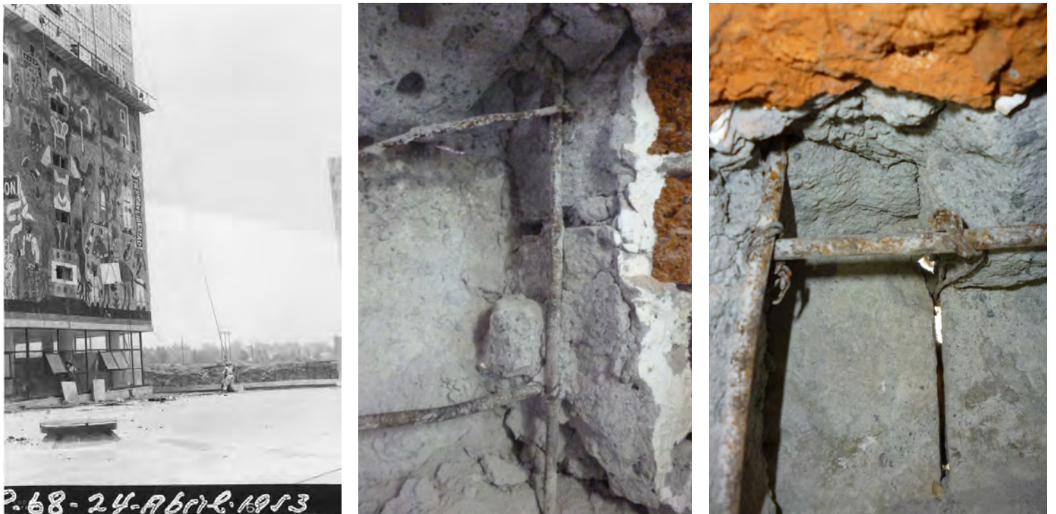
Detalle del entramado de alambón de acero que se colocaba para facilitar el anclaje de los paneles. Sep-Dic. 2012. Crédito: Virginia Arroyo Rodríguez.
