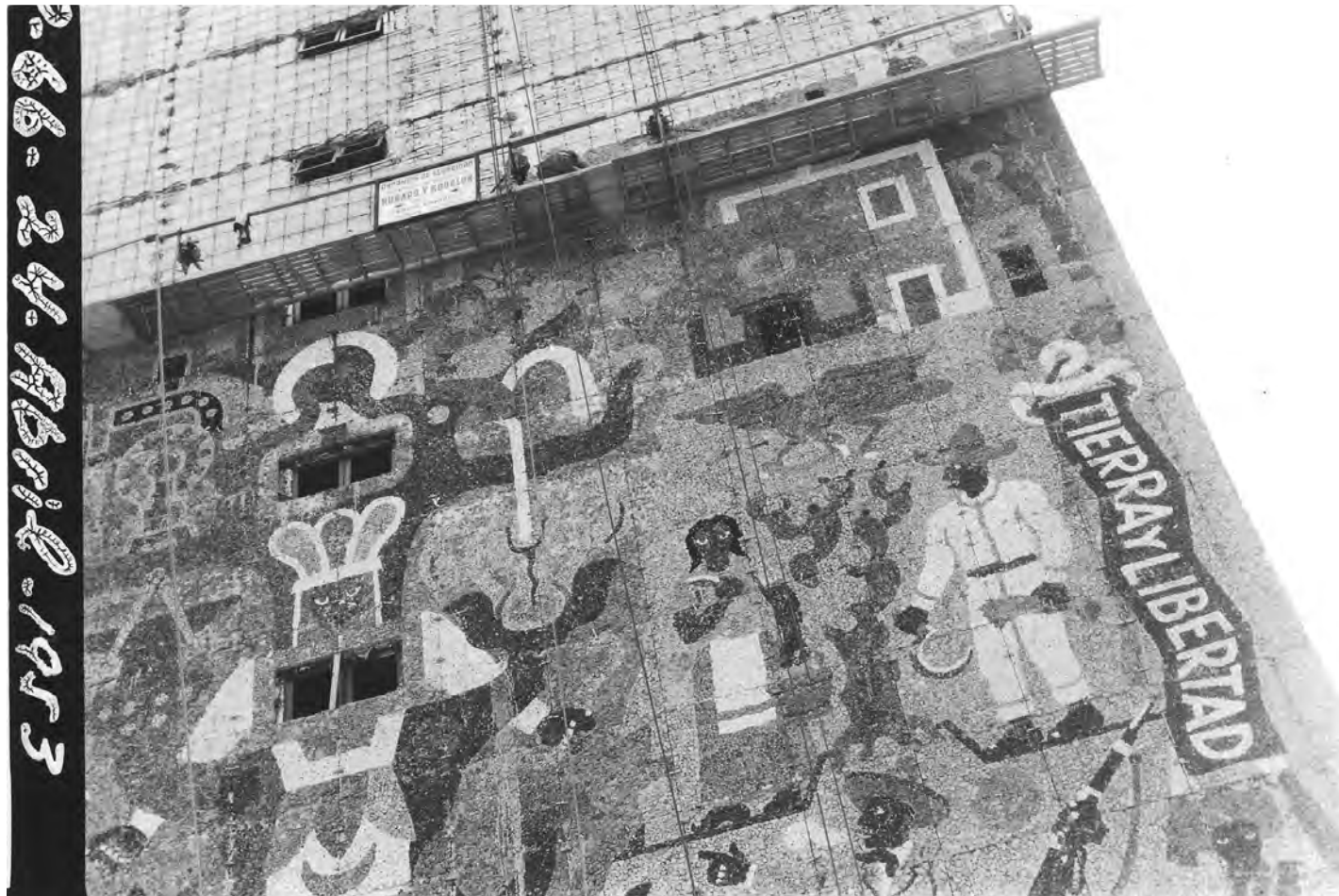
Detalle de la colocación mediante hiladas horizontales sobre la fachada Oriente. Se ven albañiles trabajando y un letrero que dice "Andamios de seguridad, patentados de alquiler por Hubard y Bourl en S.A. Ignacio Ramírez". En el margen izquierdo, fuera de la imagen, la leyenda "P-66-24-abril-1953. S/a. Imagen obtenida en: IISUE/AHUNAM/ Colección Universidad, Sección: Construcción de C.U./3454.
