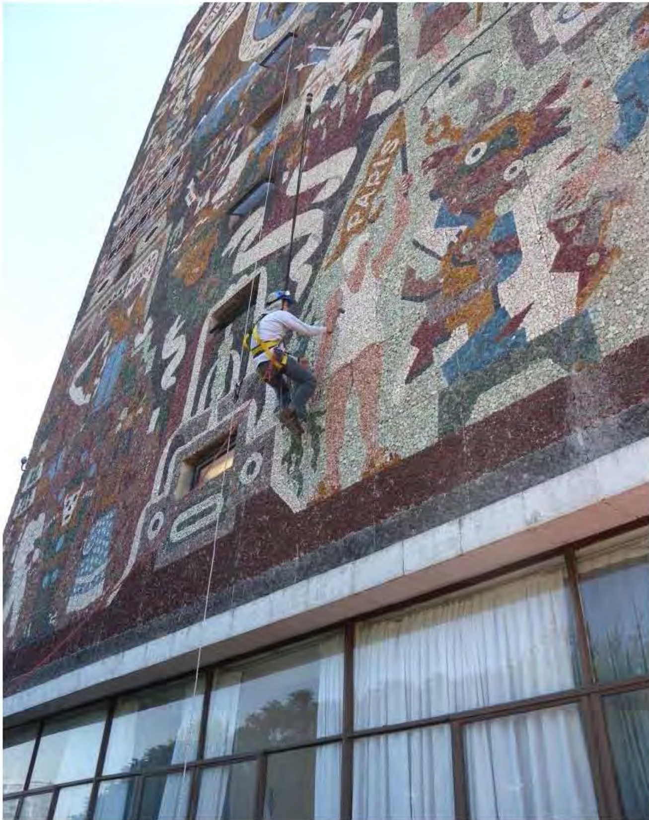
Detalle prueba de percusión sobre los paneles pertenecientes a la fachada poniente. Sep-Dic. 2012. Crédito: Virginia Arroyo Rodríguez.
