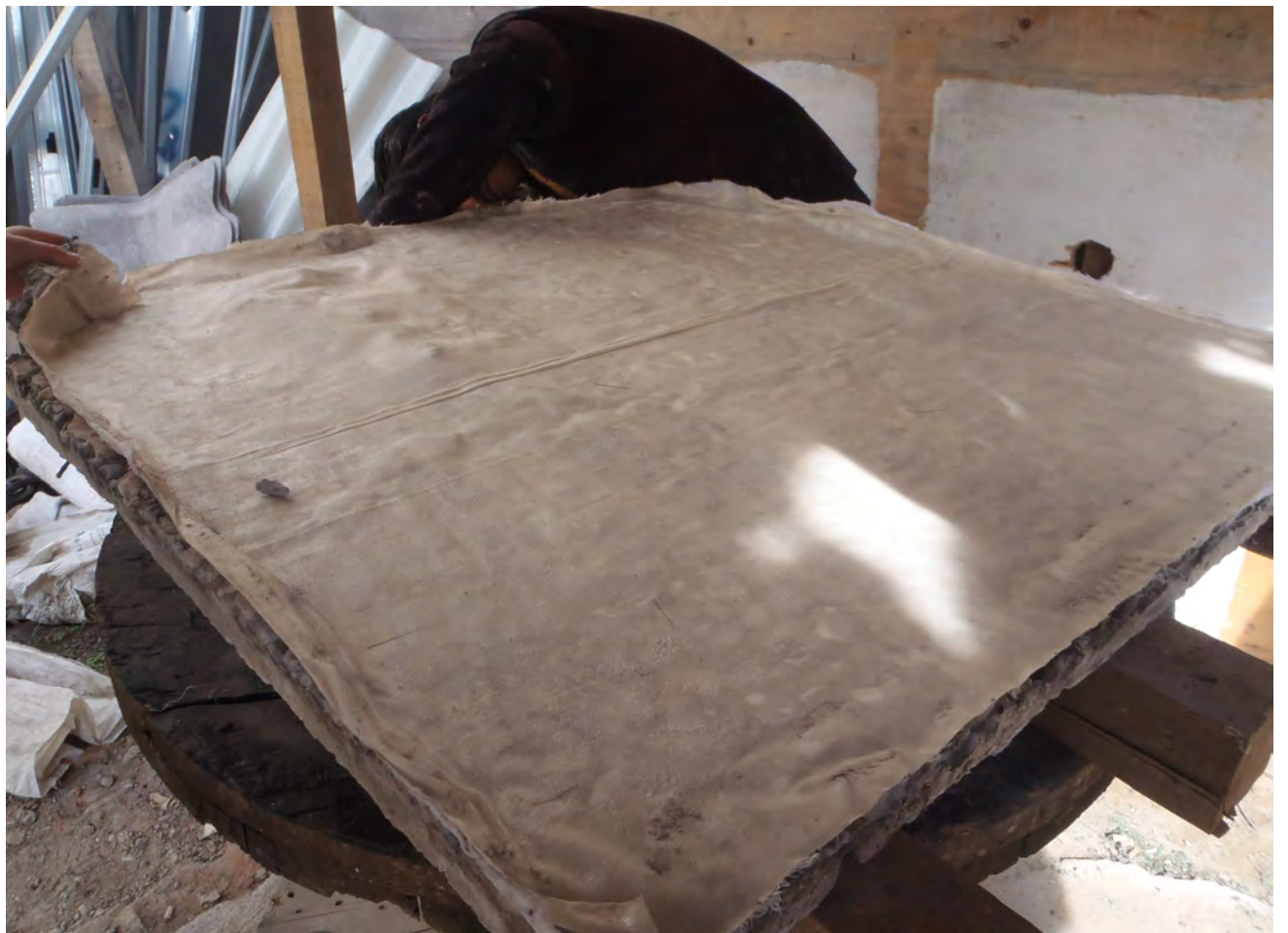
Detalle de la cara interna del panel, dónde se observan los alambres que servían para hacer al amarre de estos al entramado de alambón, mientras se realizaba el colado del concreto. Sep-Dic. 2012. Crédito: Virginia Arroyo Rodríguez.
