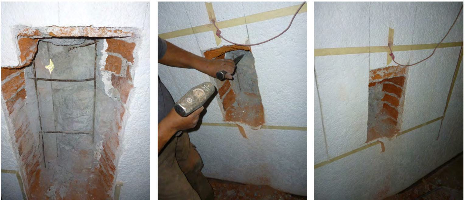
Trazo y perforación del muro al interior del edificio para realizar la liberación del panel seleccionado. Sep-Dic. 2012. Crédito: Virginia Arroyo Rodríguez.
