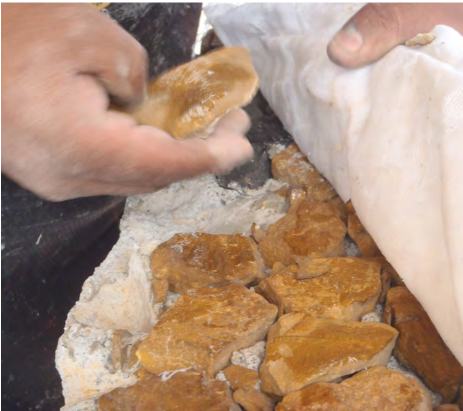
Detalle del retiro de la veladura en taller, debido a las condiciones de algunas piedras, estas se desprendían con sólo retirar la veladura. Sep-Dic. 2012. Crédito: Virginia Arroyo Rodríguez.
