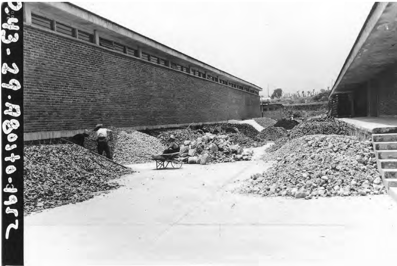
Acercamiento a pequeños montones de piedra utilizados para la construcción del mural de la Biblioteca Central. Se ven albañiles trabajando. En el margen izquierdo, fuera de la imagen, la leyenda "P-43-29-agosto-1952"; en el reverso las inscripciones manuscritas "BIBLIOTECA. P. 43.- VARIEDAD DE PIEDRA PARA MURAL.". S/a. Imagen obtenida en: IISUE/AHUNAM/Colección Universidad, Sección: Construcción de C.U./ 3449.
