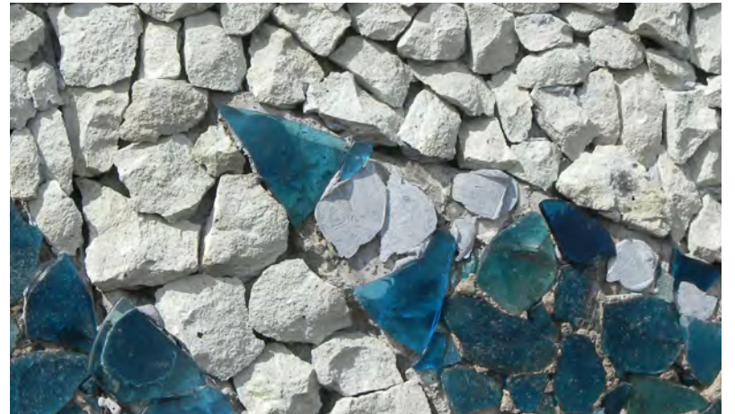
En estas imágenes se aprecia el uso de materiales totalmente ajenos a las características originales del material pétreo empleado por Juan O’Gorman y que consiguen alterar el diseño y la cromática original del mural. Sep-Dic. 2012. Crédito: Virginia Arroyo Rodríguez.
