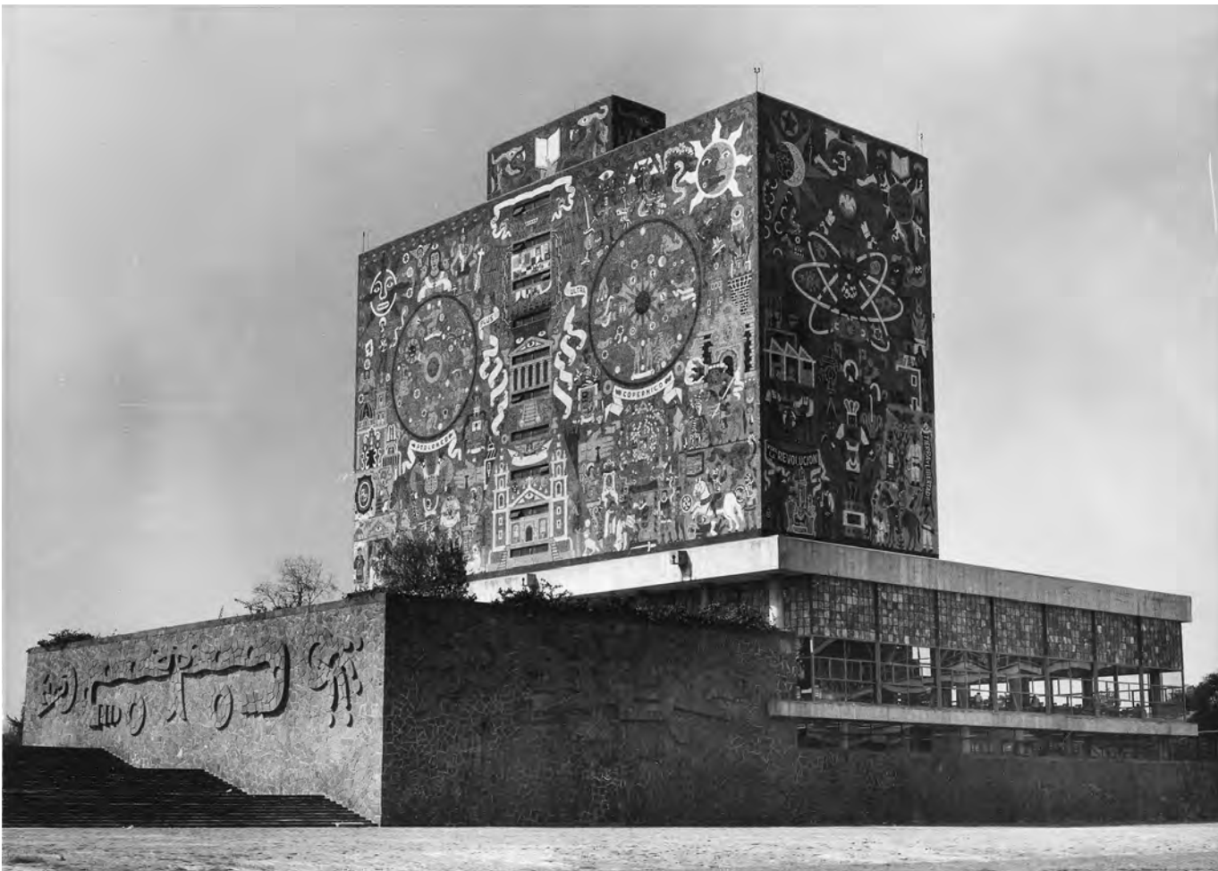
Vista general de las fachadas Sur y Este de la Biblioteca Central ya terminada. Imagen: IISUE/AHUNAM/Colección Universidad, Sección: Construcción de C.U./3461.
