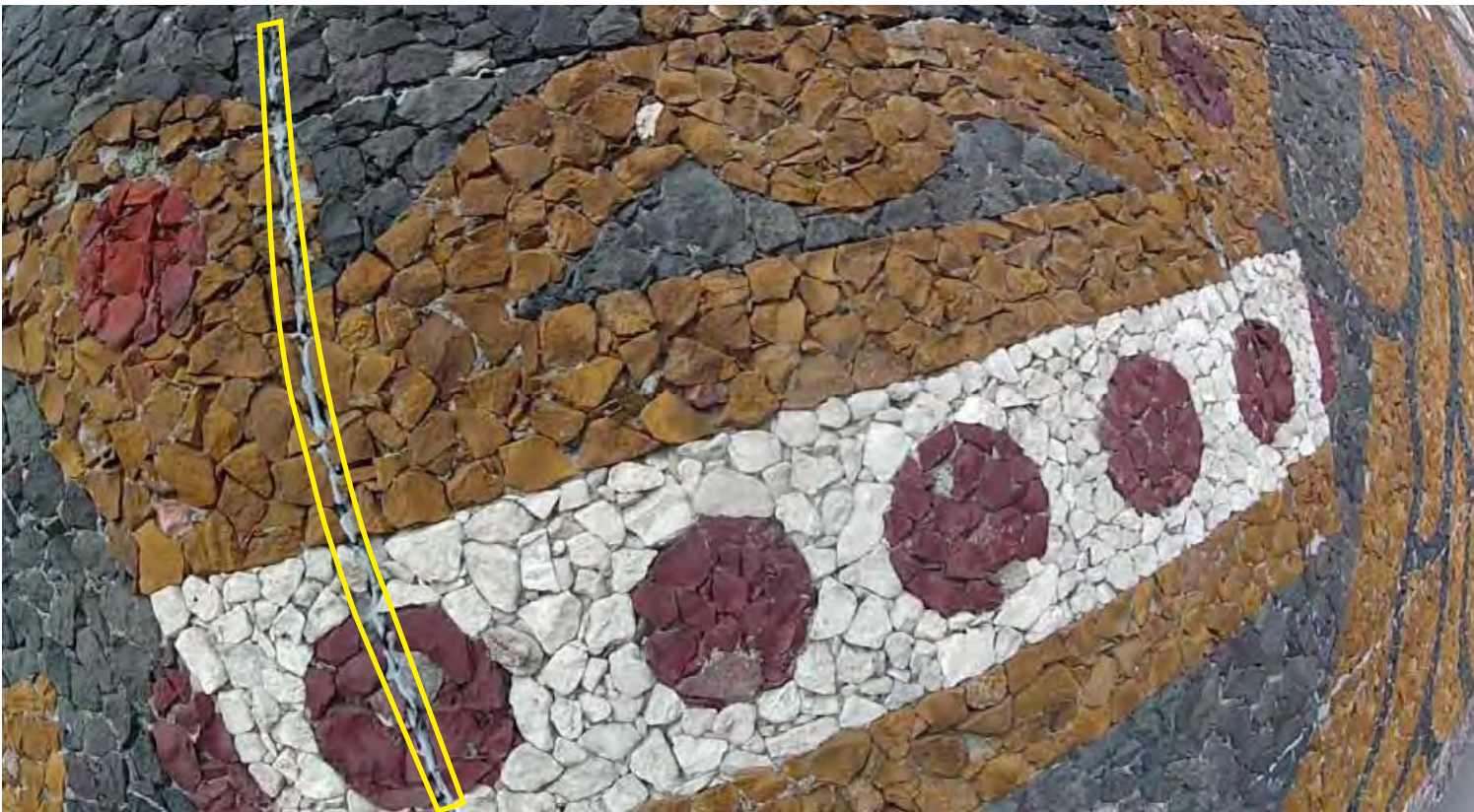
Detalle de la presencia de material epóxico en juntas entre paneles y como material para la reintegración de material pétreo, que nuevamente se ha perdido. Sep-Dic. 2012. Crédito: Virginia Arroyo Rodríguez.
