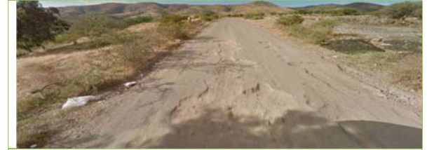
Imagen 27. Estado actual de la vía hacia el terreno.
