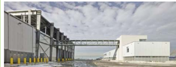
Imagen 39. Vista exterior del puente y edificios.
