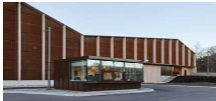
Imagen 50. Control de acceso.
