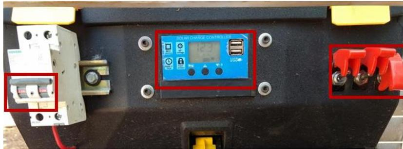
Figura 13-2 Forma en que los interruptores y panel de control deben observarse al encender el sistema fotovoltaico
