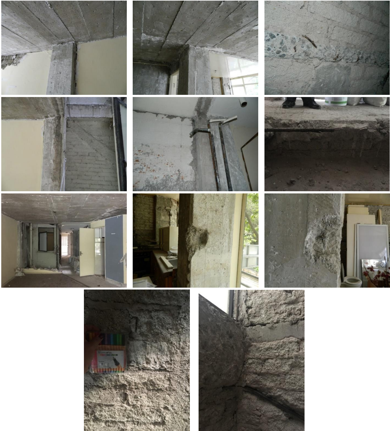
Departamento tipo Nótese sistema estructural, espesor del recubrimiento en columnas, sistema de piso y espesor de rellenos
