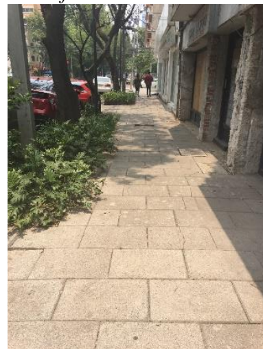
Paso peatonal fractura por asentamiento en paso peatonal
