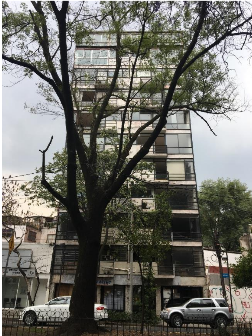
Figura 1. Fachada de edificio Sonora
