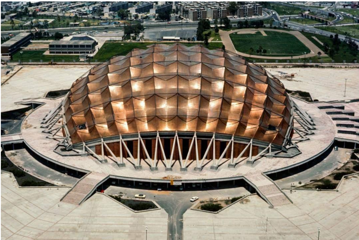
Figura. 0.1 Estructura Palacio de los Deportes
