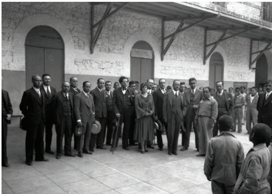
Imagen 18. Patio interior de la correccional de Tlalpan en 1932. V. Estrada Caligal. INAH.
