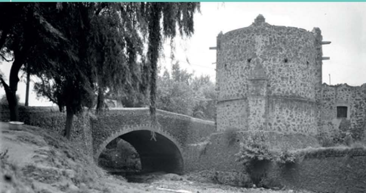
Foto 6. Puente de Panzacola, único construido en el S. XVII que sobrevive actualmente. Fuente: SINAFO.
