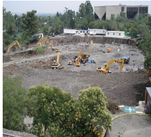
Ilustración 3: Excavación por falta de proyecto. MUAC. Foto disponible en: http://muac.unam.mx/
