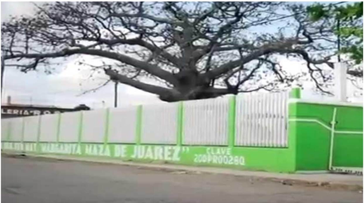
Figura 8 Escuela primaria "Margarita maza de Juárez" (antes del sismo).
