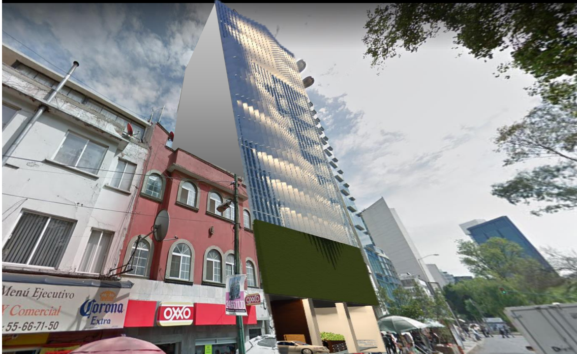
Vista desde Calle James Sullivan
