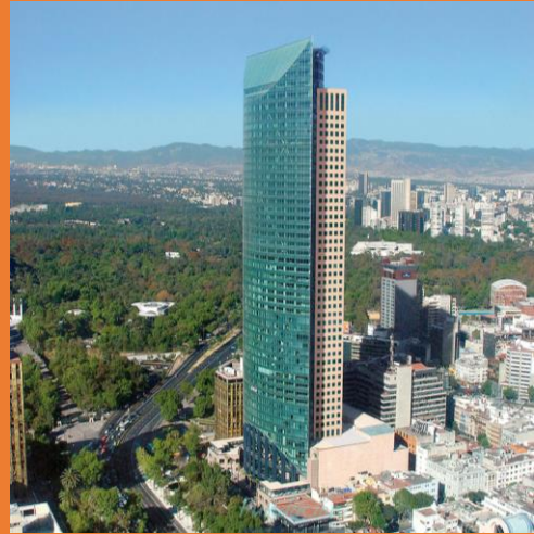
Imagen 68. Torre mayor Consultada en: https://www.archdaily.mx/mx/875123/clasicos-de-la-arquitectura-torre-reforma/595bcb16b22e38e81900035a-clasicos-de-la-arquitectura-torre-reforma-imagen
