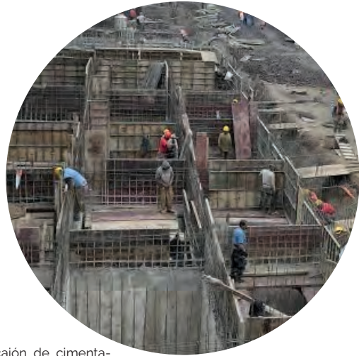
Construcción de cajón de cimentación. /Fuente: Archdaily.
