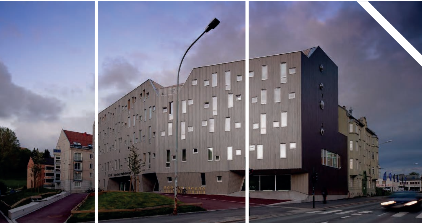
Vista exterior 2, Vivienda para Estudiantes Trondheim MEK Architects./Fuente: ArchDaily.
