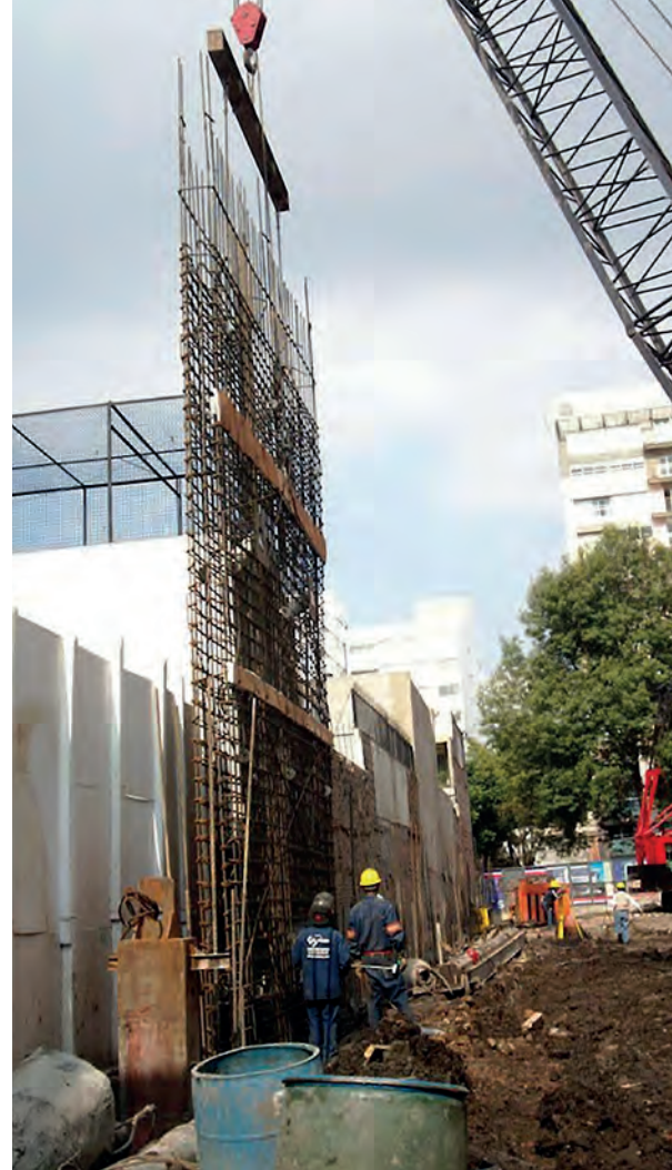
Inserción de armado en zanja. /Fuente: gruponecs.com.mx
