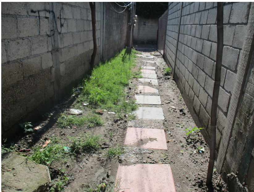
Figura 1. Calle sin pavimentación, localidad de San Miguel, municipio de Tlaltizapán, Estado de Morelos, agosto 2017.
