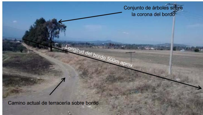
MUESTRA FOTOGRÁFICA PARA EL ANÁLISIS DE LA ESTABILIDAD DEL BORDO FUENTE: ESTUDIO DE MECÁNICA DE SUELOS 2014, GEOCON
