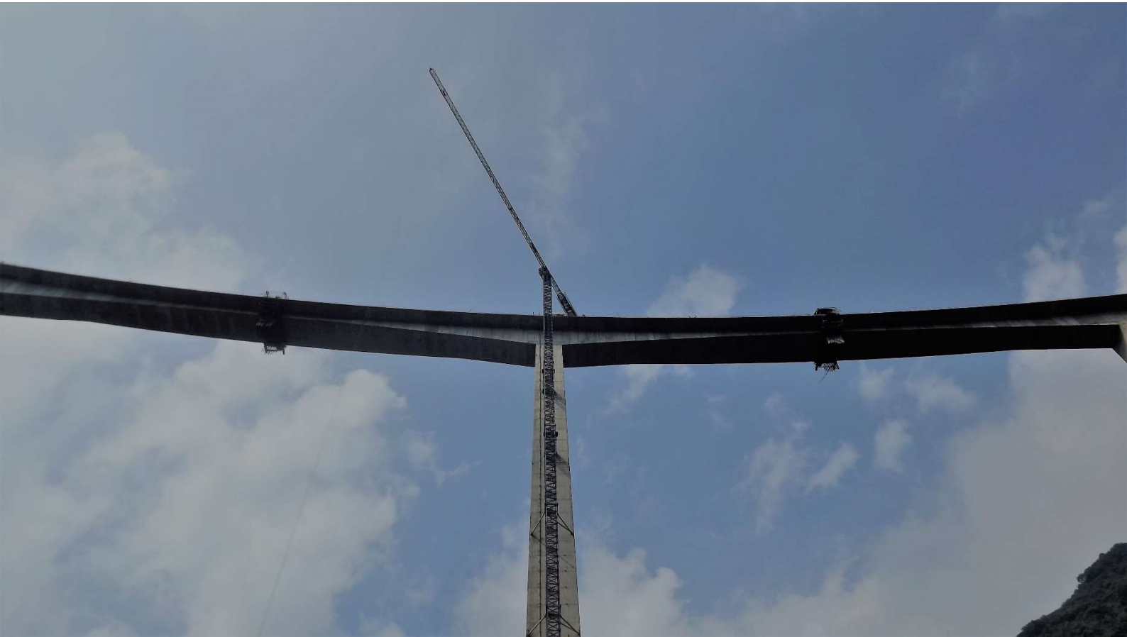
Fotografía: Puente Gilberto Borja Navarrete, Autopista Nuevo Necaxa-Tihuatlán, México 2012
