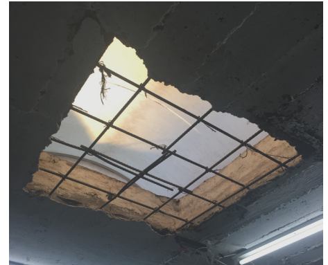
Il. 46: Domo utilizado para ventilar e iluminar la planta alta del taller Fotografía de Esaúl Hernández.
