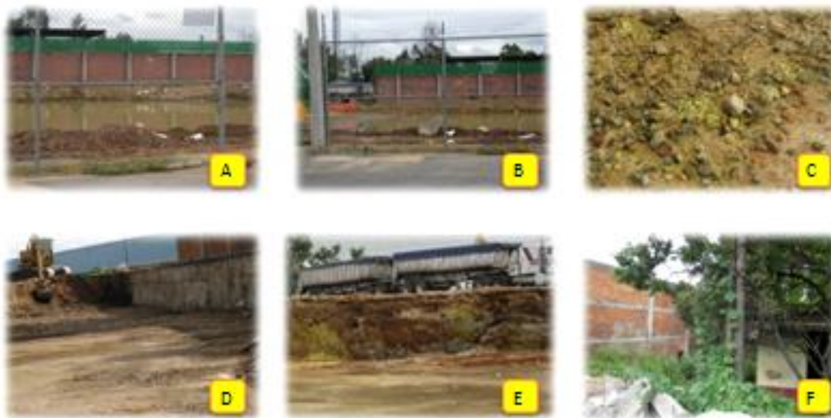
Fig. 6. Terreno de la ex fábrica de Cromatos de México. A y B: periferia del terreno cubierta solo por maya de acero; C: suelo con color amarillo debido a la presencia del Cromo; D: extracción de los residuos; E: perspectiva de la profundidad de la extracción de los residuos y el tipo de transporte utilizado; F: escuela Reforma separada por una barda del terreno de Cromatos.
