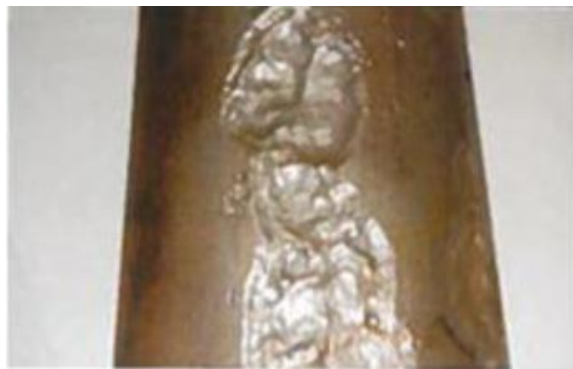
Figura 3.2 Efecto de la corrosión por SRB (Martin, Stegmann, & Sookprasong, 2016).
