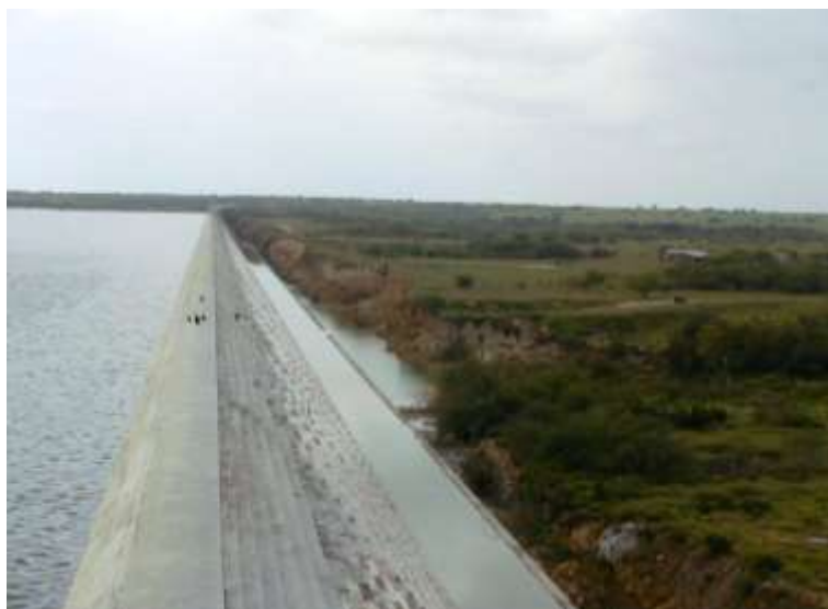
Figura 1.3 Presa las Blancas, Tamaulipas, CNA.
