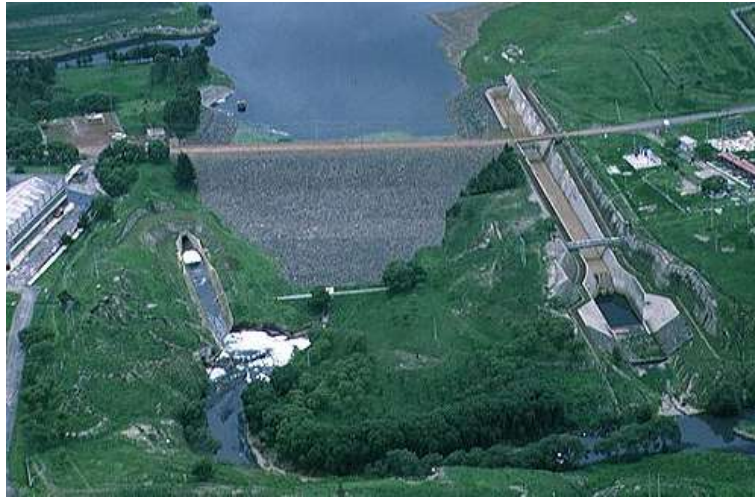
Figura 2.14 Vertedor del canal lateral de la Presa José Antonio Alzate, México, CNA.
