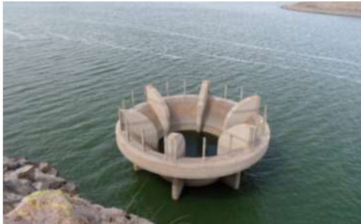
Figura 2.10 Vertedor de embudo de la Presa Chihuahua, Chih., CNA.
