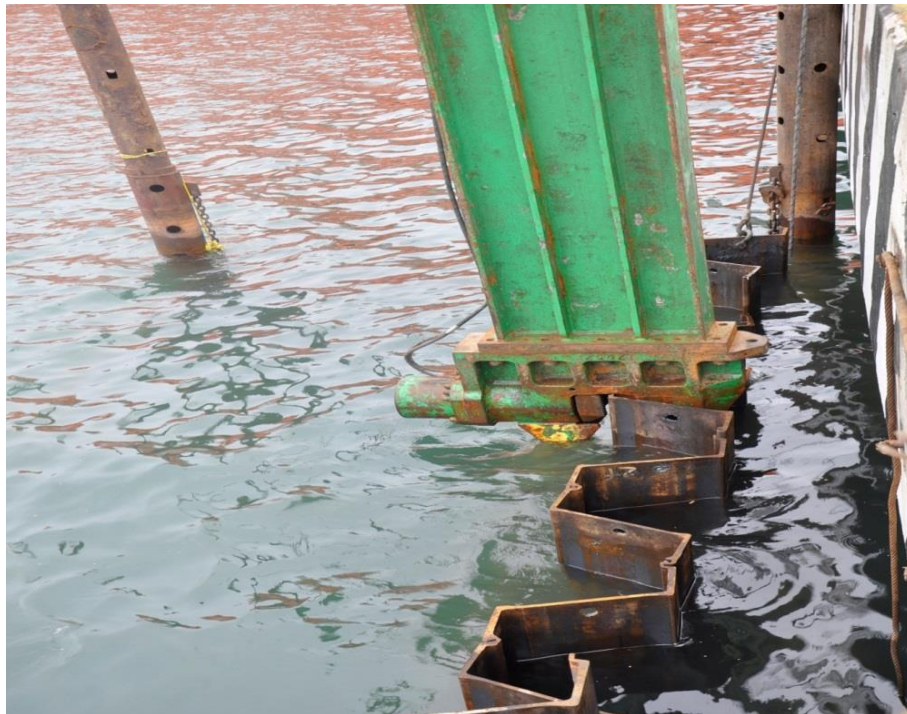
Figura. 19. Tablestaca en el Muelle Banda B en el puerto de Manzanillo, Colima
