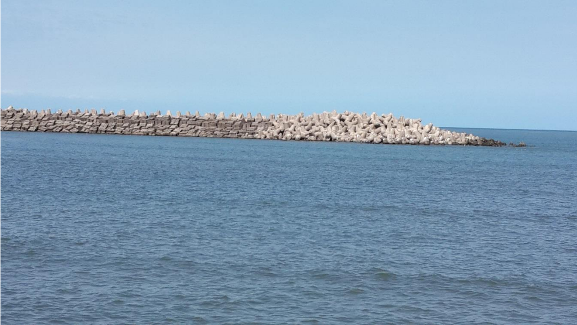
Figura. 15. Escollera en zona Portuaria Veracruz, Ver, Mex. (Combinación de bloques de concreto y tetrápodos)
