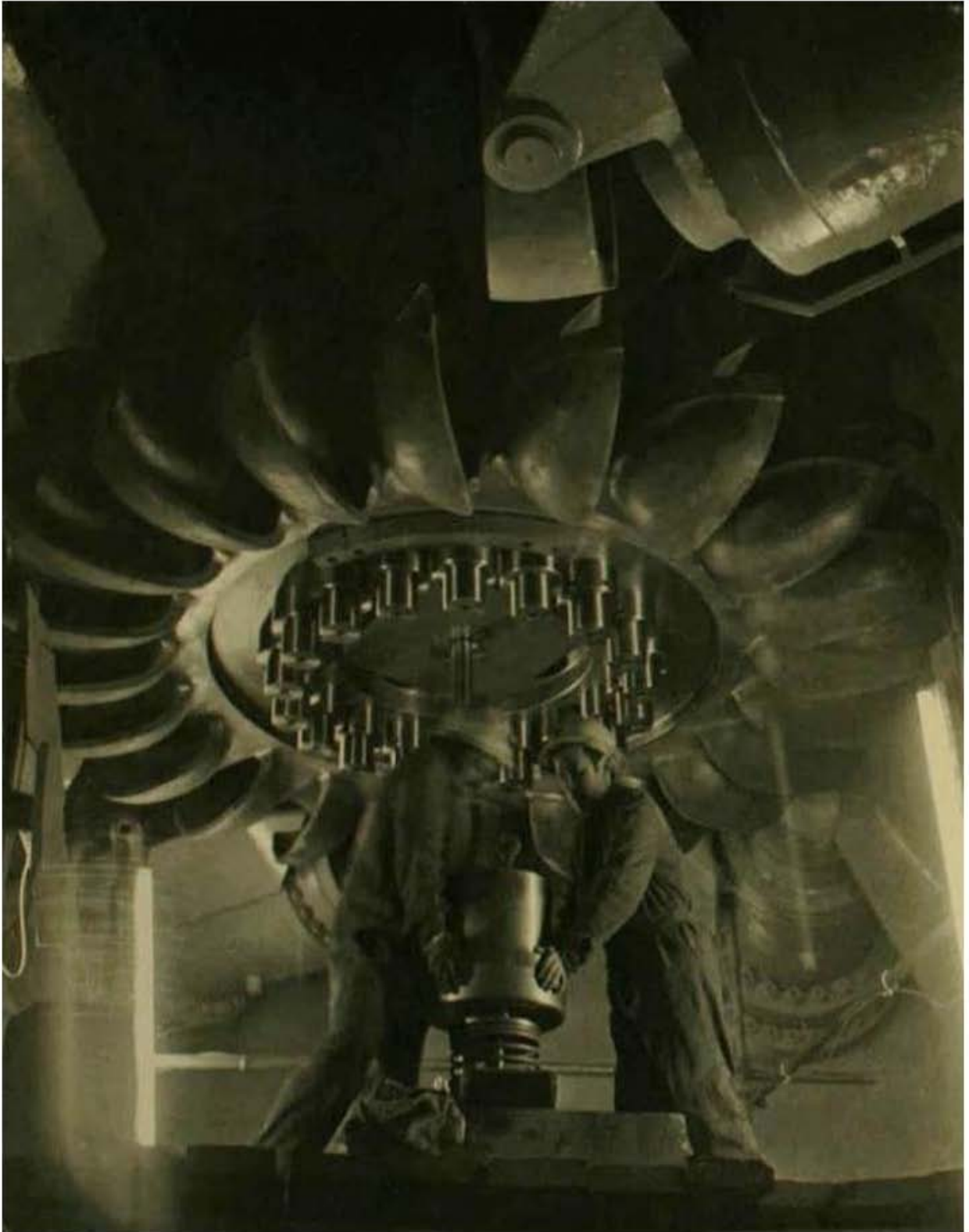
Imagen1. Montaje del Rodete de una Turbina
