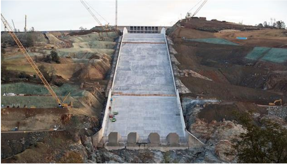
Fotografía 12. Vertedor de la presa de Oroville, Estados Unidos.
