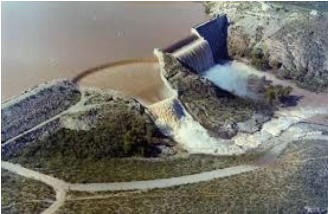
Fotografía 3. Vertedor de Abanico de la presa Francisco I. Madero o Las Vírgenes, municipio de Rosales, Chihuahua, 1949.
