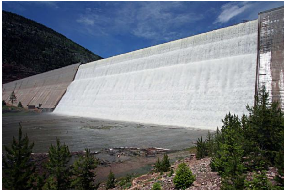
Fotografía 11. Vertedor escalonado en la presa Superior de Aguas Tranquilas o Upper Stillwater en Utah, Estados Unidos; donde Young dirigió en 1982 el primer estudio de viabilidad en este tipo de estructuras.
