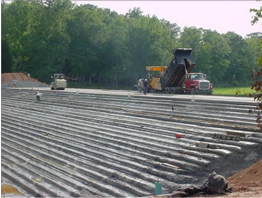
Fotografía 15. Vertedor escalonado de la presa Thomaston, construido con CCR.
