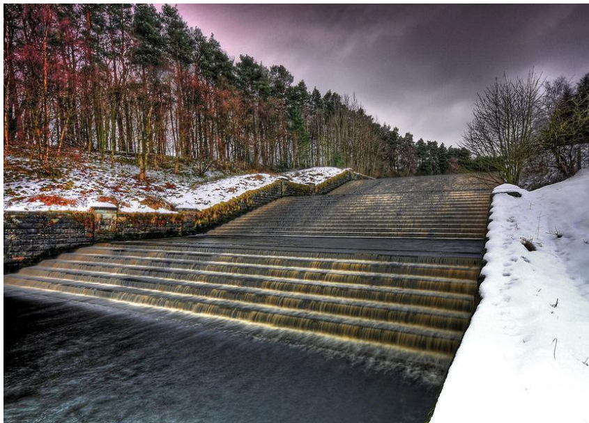
Fotografía 7. Vertedor escalonado de la reserva Fewston, Inglaterra.
