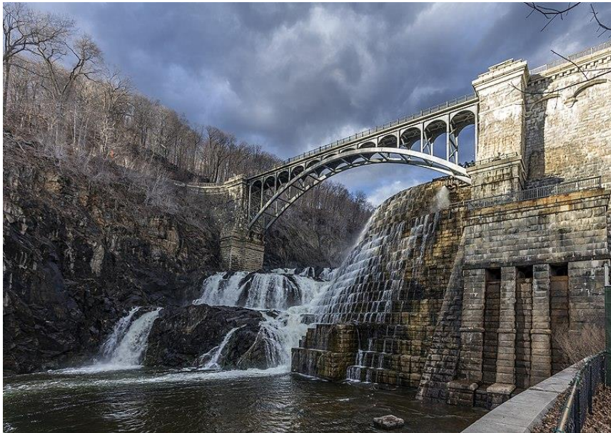
Fotografía 10. Vertedor escalonado de la presa New Croton, Estados Unidos.
