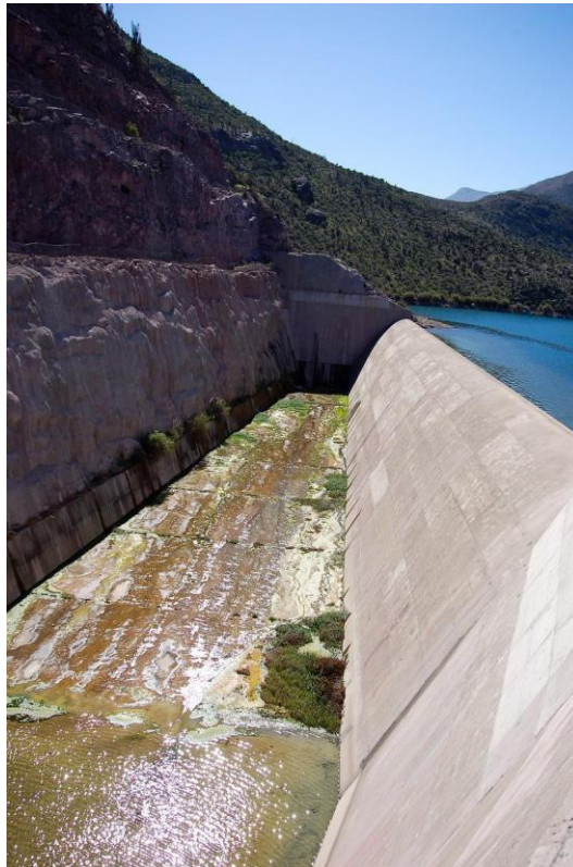
Fotografía 6. Vertedor lateral sobre el embalse de Puclaro en Chile.
