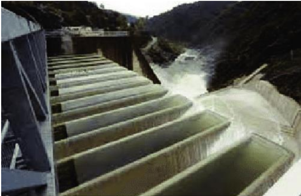
Fotografía 5. Vertedor de Teclas de piano o PKW, en la presa de Malarce sobre el río Chassezac en el sur de Francia.
