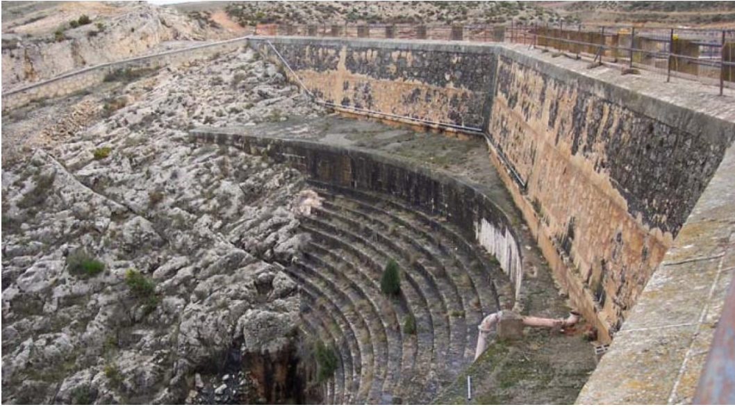
Fotografía 8. Estructura de descarga escalonada en la presa de Almansa, España.
