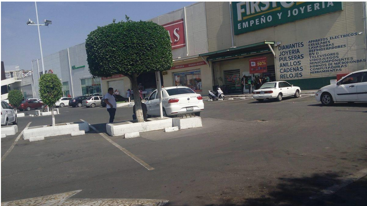
Locales comerciales del lado derecho de la plaza, además sobre este se encuentra la entrada peatonal principal, se alcanza a observar el puente que servía como conexión con el paradero y el centro comercial, además de las escaleras que llevan a una entrada de la plaza.
