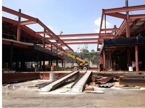
Etapa de construcción Arquitectura Panamericana
