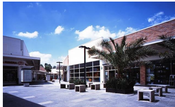
Interior del conjunto. Grupo Arquitech
