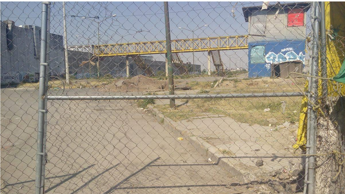
Se muestra la entrada al predio, se observa el desnivel generado por la falla geológica y de fondo el puente que comunicaba al paradero con la plaza.
