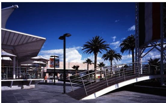
Interior del conjunto. Grupo Arquitech
