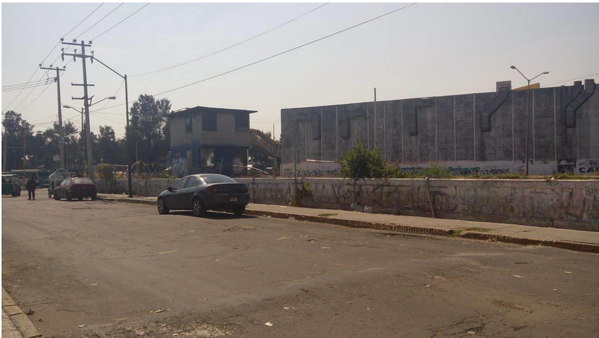
Vista sur del paradero abandonado tomada sobre la calle Jesús Carrillo, la pequeña edificación que se observa tenía la función de servir como caseta de vigilancia en el paradero.
