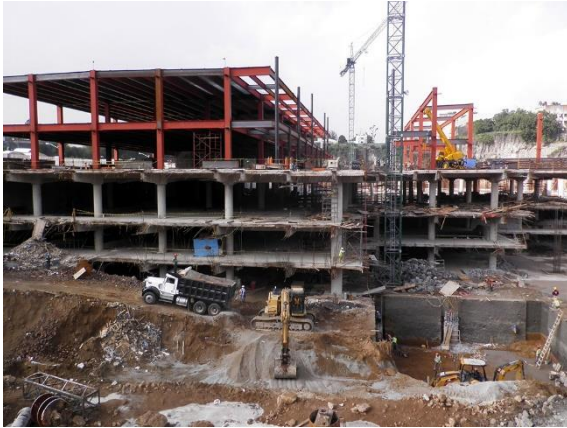
Etapa de construcción Arquitectura Panamericana
