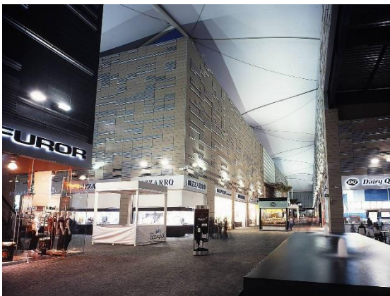
Paseo Acoxpa Grupo Arquitech
