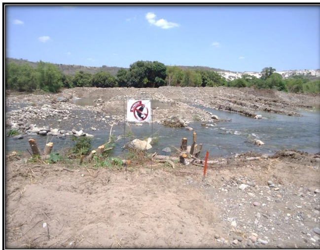
Imagen 31. Retiro de señalamientos.
