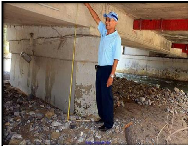
Imagen 10. Medición del azolvamiento del río.
