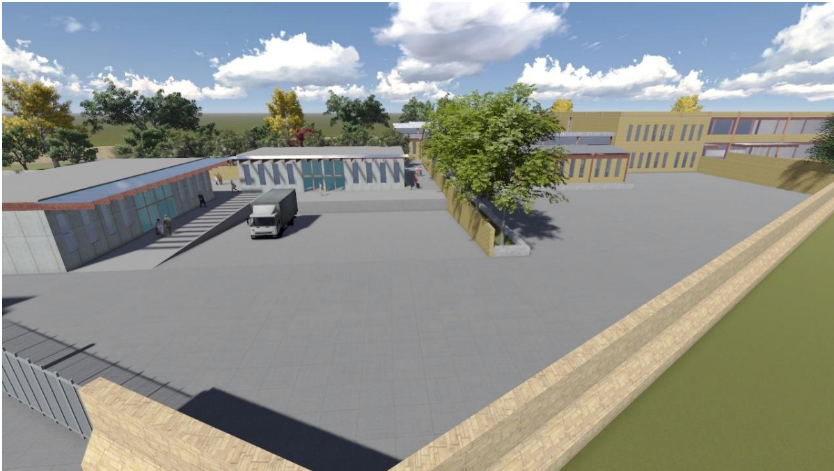
Patio de maniobras y taller de prácticas de mecánica automotriz
