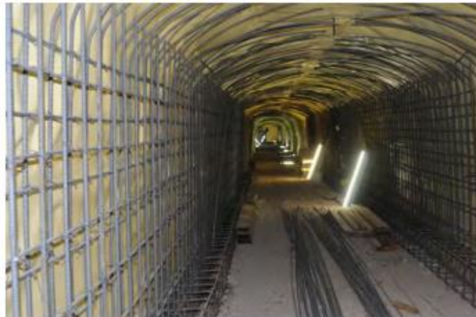
Figura A.2. SCT. (2016). Instalación de Geomembrana. [Figura]. Manual de Túneles Carreteros, Cap. 12.
