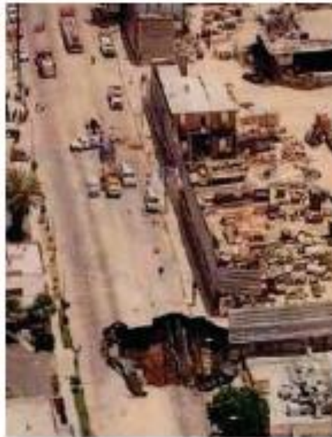
Figura 6. Civil Engineering International (1995). Colapso en Metro de Los Ángeles, EEUU.
