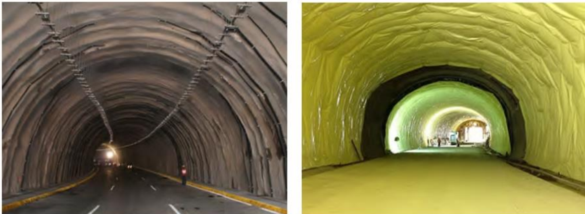
Figura A.1. SCT. (2016). Túnel sin impermeabilización y túnel con geotextil y geomembrana. [Figura]. Manual de Túneles Carreteros, Cap. 12.
