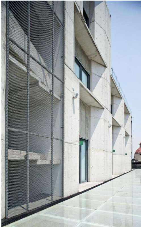
Vista de escaleras
